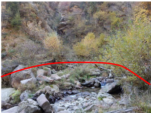
Fotografia 26 - Vista d'insieme dell'attraversamento sul Rio Penna.
