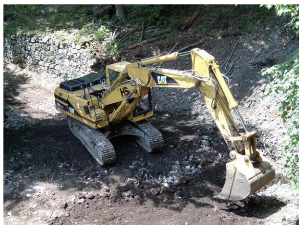
Costruzione di un guado con andamento “a corda molle” e scogliera di sostegno. Preparazione del letto di posa: è questa la fase più importante in cui si crea la forma del futuro guado, le opere successive sono solamente di rivestimento (Mosso Santa Maria - BI).
