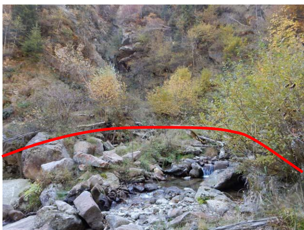
Fotografia 26 - Vista d'insieme dell'attraversamento sul Rio Penna.
