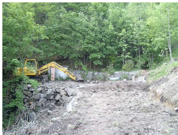
Fasi di costruzione di un ampio guado con andamento “a corda molle” e scogliera di sostegno (Mosso Santa Maria - BI).
