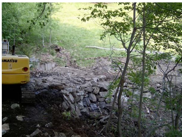
Fasi di costruzione di un ampio guado con andamento “a corda molle” e scogliera di sostegno (Mosso Santa Maria - BI).
