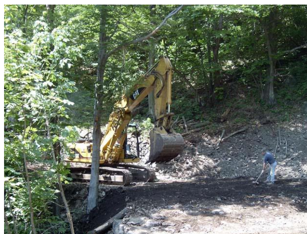
Costruzione di un guado con andamento “a corda molle” e scogliera di sostegno. Preparazione del letto di posa: è questa la fase più importante in cui si crea la forma del futuro guado, le opere successive sono solamente di rivestimento (Mosso Santa Maria - BI).
