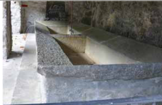
Lavatoio in cui si vedono le lastre che rivestono l'interno della vasca, mentre i fianchi esterni sono in muratura intonacata - Cravagliana, fraz. Meula
