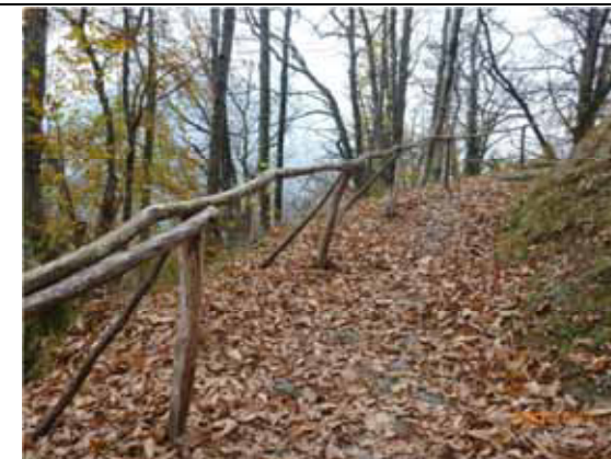
Una staccionata, particolarmente aerea e leggera, indica la presenza di un dirupo, senza la pretesa di fungere da parapetto anticaduta - strada comunale Sabbia - Brugaro di Cravagliana
