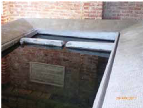
Lavatoio realizzato interamente in cemento, in cui vengono riproposti gli elementi tipici delle vasche in pietra: scivolo con bordino di raccolta dell'acqua, setto divisorio interno – Borgosesia, fraz. Ferruta
