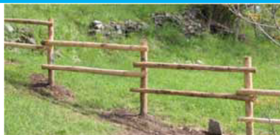
Staccionata su pendio con elementi posati 'a scalare'. I pali sono infissi nel terreno per una profondità di circa 50 cm. Il legno utilizzato è castagno locale, scortecciato e privo di trattamenti. Sotto la recinzione si intravede un termine in pietra che indica il confine di proprietà - Cravagliana, fraz. Brugaro
