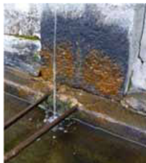
Crescita di vegetazione infestante, degrado biologico, efflorescenze saline e incrostazioni - Scopello e Scopa
