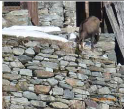
Gneiss e gneiss anfibolitici, sbazzati a mano - Campo Ragozzi (Rimasco)
