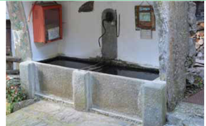
Pulitura della pietra, ma sigillature esterne troppo evidenti - Cravagliana, fraz. Meula
