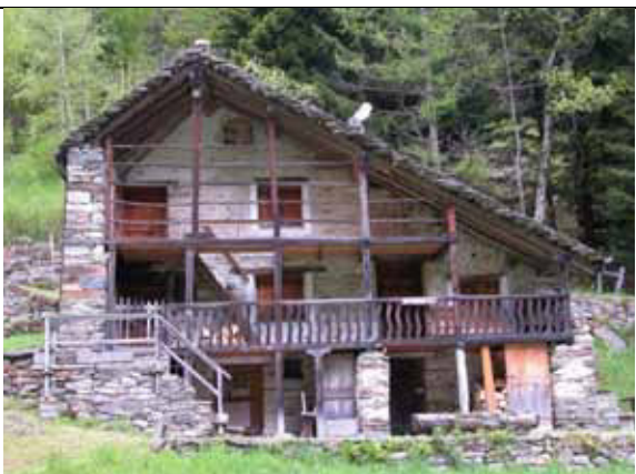
Casa caratterizzata dal colmo del tetto non centrale rispetto alla facciata - loc. Quare
