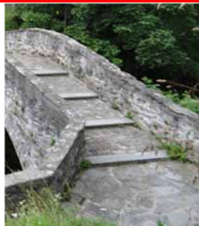
Sopra: interventi di ripristino o nuova esecuzione di pavimentazioni e murature parapetti, eseguite con sovrabbondante allettamento in malta cementizia, o con pastina di cemento, e/o impiegando elementi lapidei non adatti (lastre in formati regolari e superfici lisce, coste rettificata a macchina, spigoli vivi). NON AMMESSI
