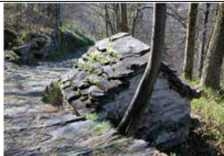
Muraglione della mulattiera addossato alla cappella (o cappella addossata al muraglione?) - Pila, sentiero per fraz. Micciolo
