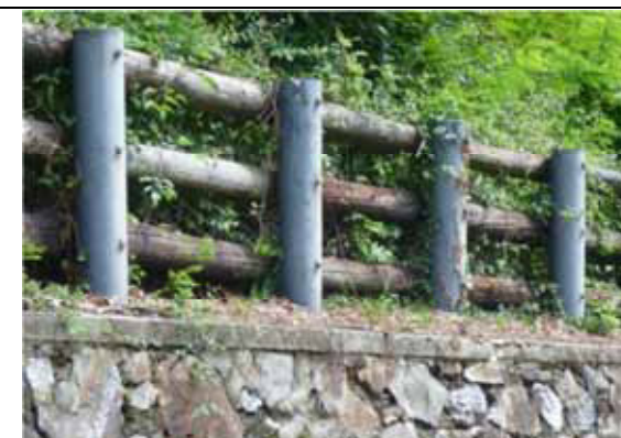
Barriera robusta per impedire il rotolamento di grossi massi sulla carreggiata stradale - Varallo Sacro Monte
