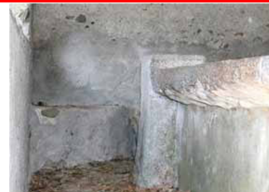
L'impiego di malta cementizia, sia come rinzafo sulle facciate esterne, sia come intonaco applicato nella parte bassa della parete, all'interno, ha accentuato i danni causati dall'umidità di risalita nel muro in pietrame, impedendone la traspirazione. Sulla muratura si vede la zona di degrado a circa 1,5-2 m da terra, corrispondente alla fascia al di sopra delle parti in cemento
