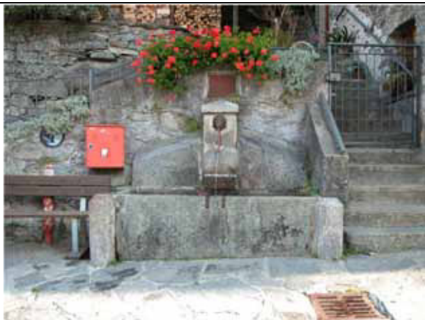
Fontana datata 1893 in pietra a lastre assemblate, con pilastri angolari e un lato addossato alla parete retrostante - Piode
