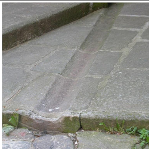
31- Mollia fraz. Grampa: pavimentazione a lastre con canaletta di scolo in gneiss massiccio
