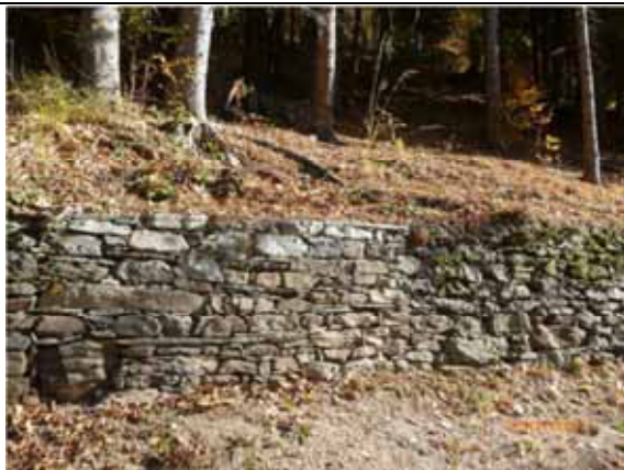
Muretto in gneiss tabulare, lavorato a mano e posato a corsi regolari - Rossa
