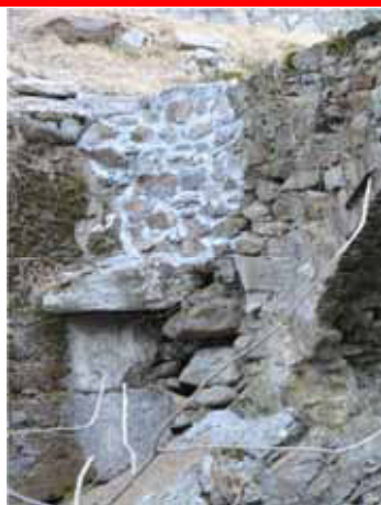
Ponte ad arco con spalle in muratura di pietrame sconnessa e pericolante (foto a destra), ripristinata ricostruendo parte del vecchio muro con abuso di malta cementizia (foto a sinistra). NON AMMESSO
