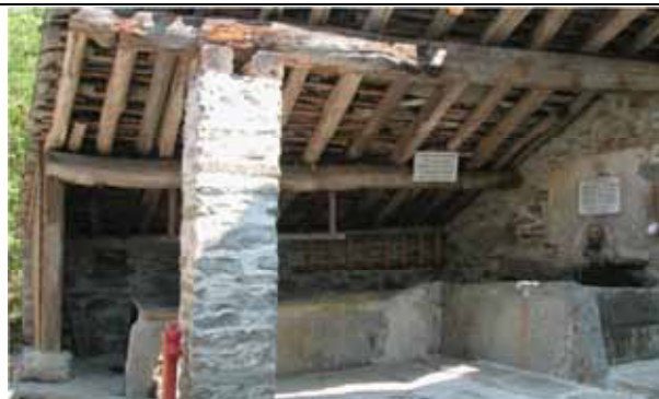
Pregevole e antico complesso coperto da tetto in piode, con fontana e lavatoio, entrambi di tipologia a lastre assemblate, collegati da canalino scavato in un masso in pietra – Mollia, fraz. Grampa
