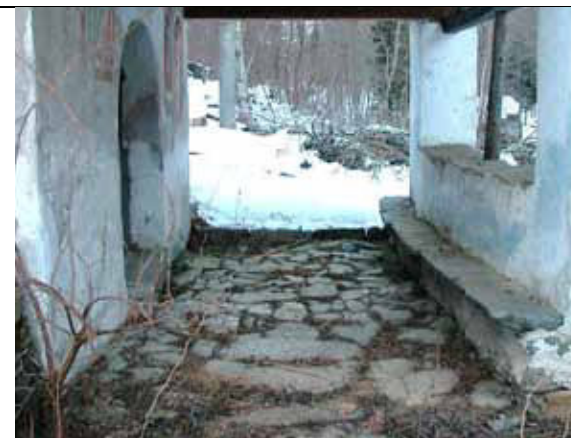
Vecchio selciato in pietre di provenienza locale e di varia pezzatura posate senza ausilio di malta - portico cappella al bivio per fraz. Sause
