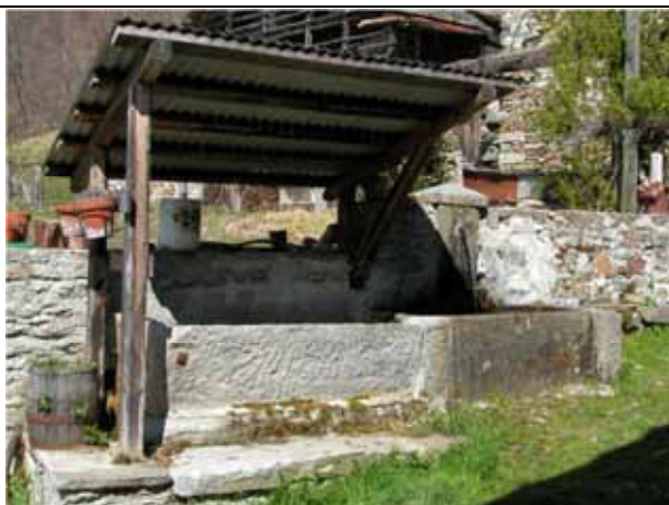
Fontana affiancata da vasca-lavatoio, di epoca più recente provvista di tettoia, entrambi a lastre assemblate – Pila, fraz. Villabella
