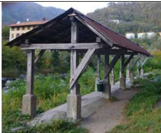
Soppressione dell'antico lavatoio e conservazione della vetusta tettoia - Varallo
