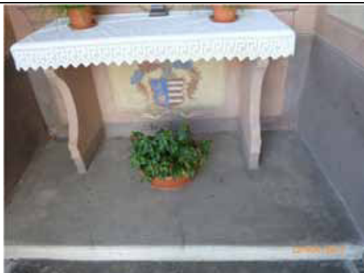
Pavimento interno in pastina di cemento - Boca
