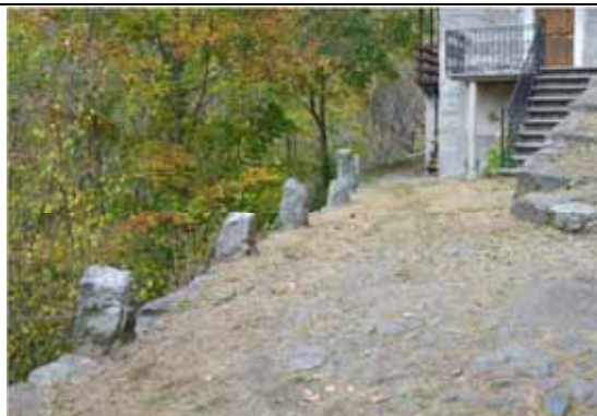
Alcune pietre, grossolanamente sbazzate e posizionate verticalmente indicano il margine della mulattiera - Cravagliana, fraz. Brugaro
