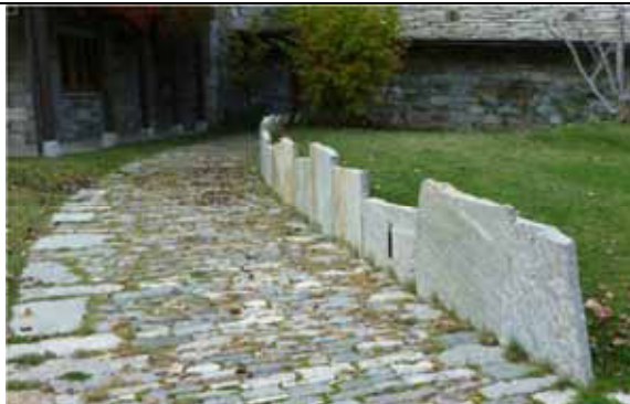
Lastre di pietra di Luserna di dimensioni e formato variabile, ma abbastanza regolare, con superficie e coste a spacco, infisse verticalmente nel terreno per delimitare un percorso pedonale
