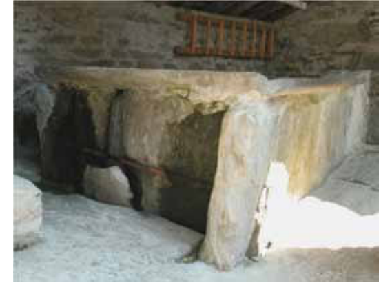
Nell'antico e pregevole complesso, il lavatoio ha la vasca costituita da più lastre assemblate e vincolate da tirante metallico esterno e viene alimentato dal troppo piena dell'adiacente fontana - Mollia, fraz. Grampa
