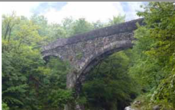
Vecchio ponte Barattina-Cervarolo (Varallo)
