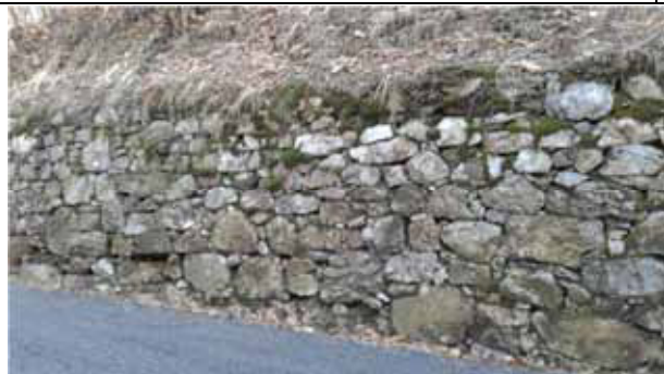
Muretto di contenimento terreno lungo una strada, eseguito con pietre in gneiss della serie kingizitica - Parone
