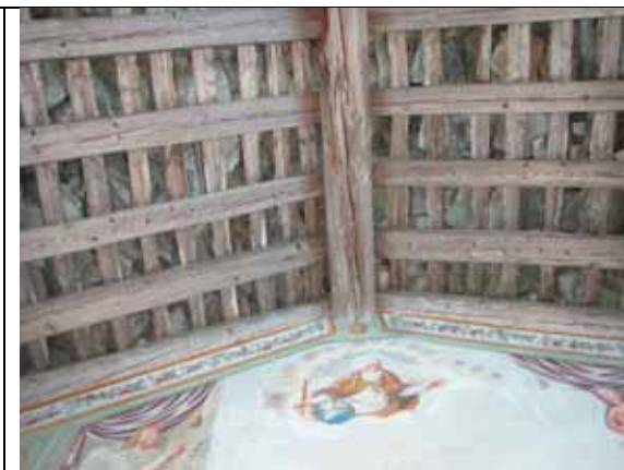
Intradosso del tetto coperto in piode locali della cappella posta al bivio per frazione Sause
