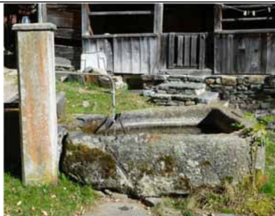
Antica fontana scavata in un masso di pietra con pilastro recente in cemento - Alagna, fraz. Goreto
