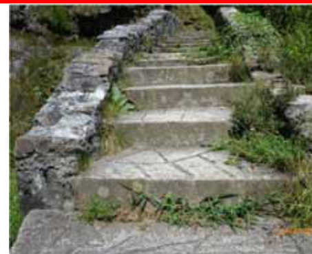
Sopra: interventi sulla muratura dei fianchi, delle spallette e dei parapetti, eseguiti con getto di calcestruzzo, o con impiego di intonaco cementizio. NON AMMESSI
