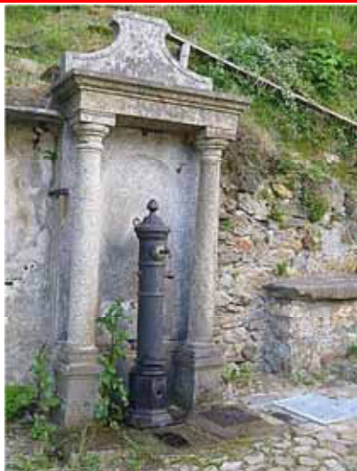
Rinzaffo di malta cementizia su muri in pietra a secco
