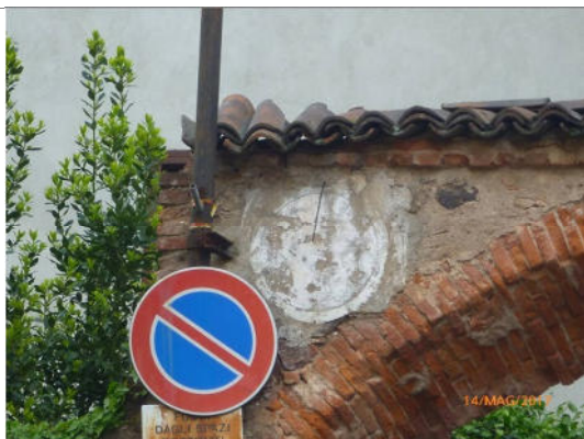
Arco in laterizi - Maggiora
