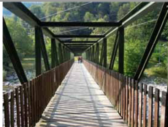
Ponte pedonale della Selva, sul Mastallone, relativamente recente, a trave reticolare (Cravagliana)
