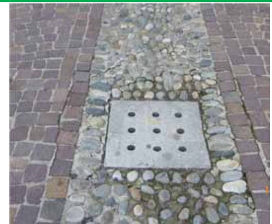
Caditoia in pietra inserita in fascia di pavimentazione ad acciottolato - Boca
