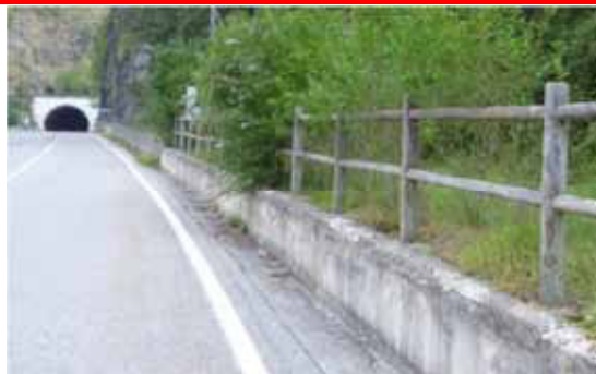
Staccionata infissa in muro in cemento armato costituita da pali tondi a due fori per inserimento delle traverse passanti. Legno di conifera con trattamento protettivo effettuato in autoclave ed elementi torniti a sezione e lunghezza costanti
