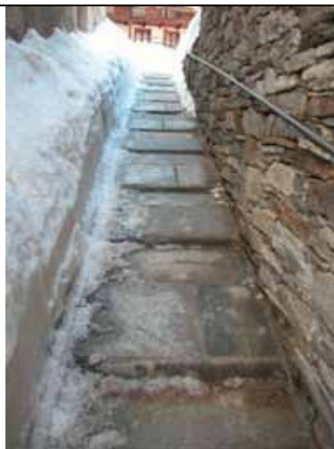
Rampa pavimentata con nuove lastre di pietra di grande formato (pietra di Luserna) - fraz. Rima
