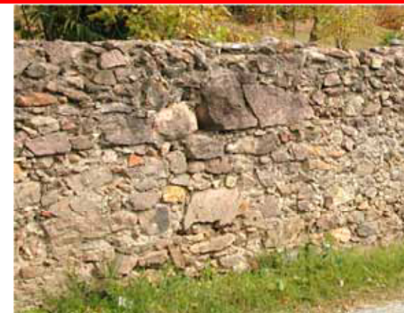
Allettamento con malta
