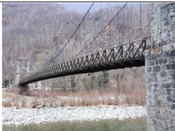
Ponte sospeso di Morca (Varallo)
