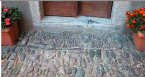
Nell'acciottolato di un cortile, pietre sottili (pietre verdi e calcescisti locali) posate di costa realizzano una sorta di zerbino sulla soglia di una casa - Alagna
