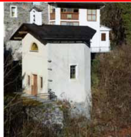
Nuovo tetto coperto in lamiera in sostituzione delle piode
