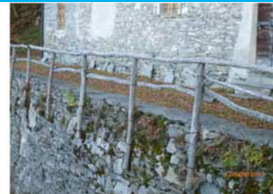
Parapetto in legno fissato all'esterno del muraglione: perfetta l'armonia cromatica tra legno naturalmente invecchiato e pietre dei muri - Boccioleto, Madonna del Sasso
