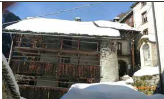
Loggiato in legno esteso anche sul lato lungo dell'edificio - fraz. Campo Ragozzi
