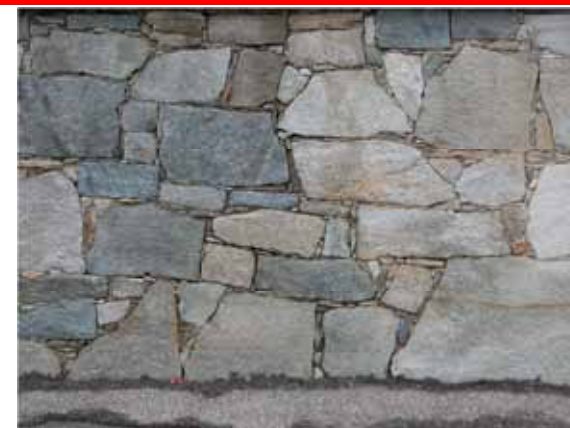
Superficie perfettamente a filo per un muretto in pietra a vista, con elementi lavorati e messi in opera con malta e minuziosa scagliatura dei giunti
