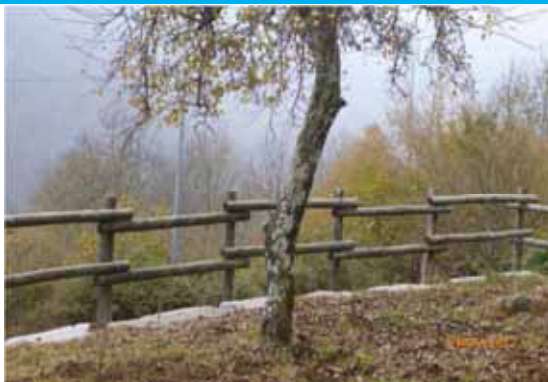
Parapetto in legno di castagno lasciato naturale, con tipologia a staccionata con doppia fila di traverse, fissato all'esterno del muro di contenimento - Cravagliana, fraz. Brugaro
