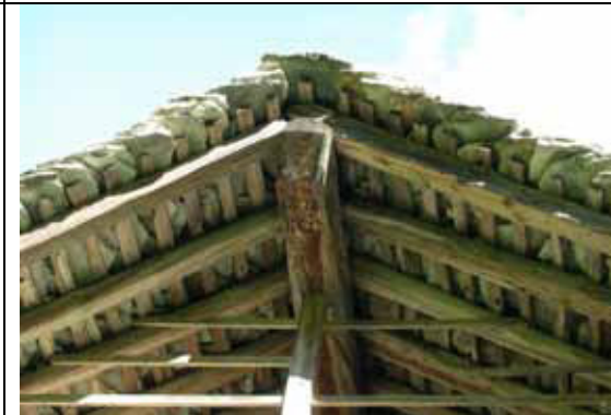
Intradosso di tipico tetto in piode con trave di colmo datato 1874
