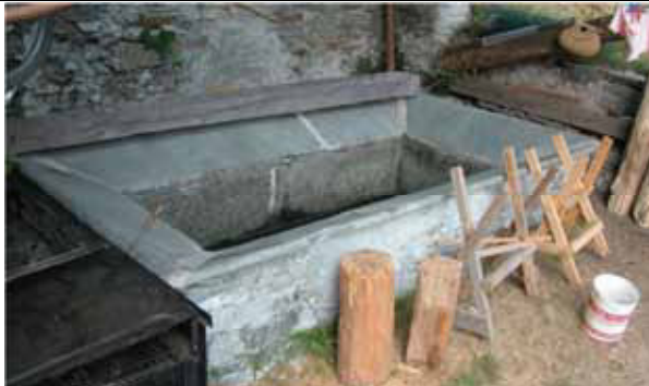
Vasca con fondo, pareti interne e bordo inclinato (scivolo) realizzati in lastre di pietra locale (gneiss); esternamente i fianchi sono intonacati - Boccioleto, fraz. Piaggiogna
