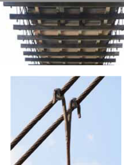
Ponte del Baraggiolo (Varallo) Di proprietà privata, venne costruito intorno al 1890. Si notano recenti interventi di manutenzione straordinaria con sostituzione di alcune travi e tavole dell'impalcato.
