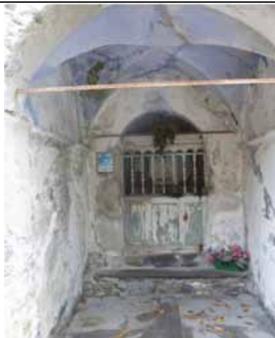
Cappella con vano interno accessibile, lastricato intonacato e coperto a volta; abside affrescata, separata da cancello in legno - Scopa
