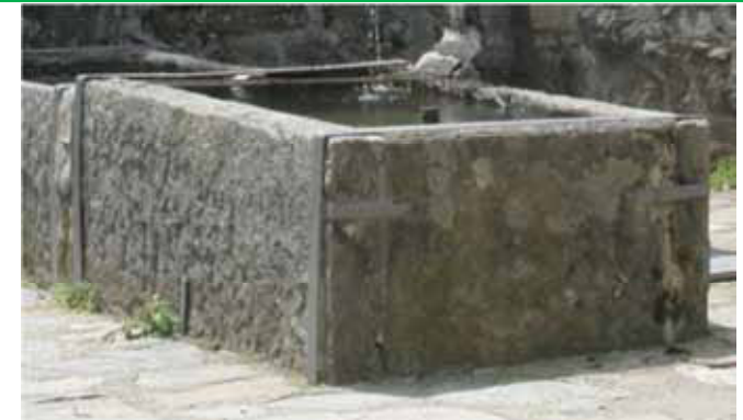
Nonostante l'esecuzione risulti un po' vistosa e pesante, si apprezza la coerenza con la tecnica costruttiva tradizionale dell'intervento di consolidamento mediante cerchiatura metallica esterna che vincola tra loro le lastre della vasca - Rimasco, fraz. Campo Ragozzi
