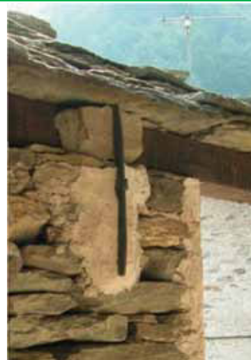
Capochiave di modello tradizionale per il nuovo tirante inserito - Boccioleto, fraz. Piaggiogna
