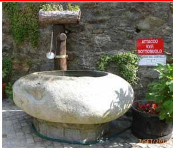
Nella tipologia tradizionale di fontane a bacino monolitico, il masso posa sempre direttamente al suolo, non è posato al di sopra di un collare che, per quanto funzionale all'impianto di scarico, risulta inopportuno e non congruente
