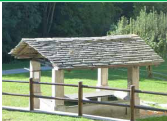
Vocca, fraz. Sassiglioni: vista esterna, con ripristino della muratura e degli intonaci dei pilastri e rifacimento della copertura con manto in piode
