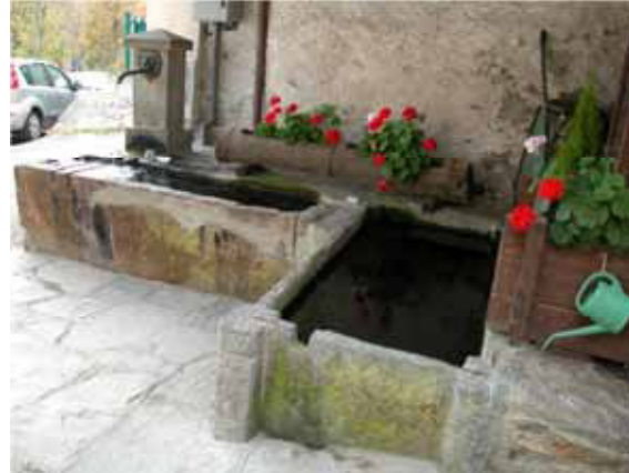
Vasca-lavatoio realizzata con lastre di pietra assemblate mediante incastro nei pilastrini angolari, collegata a fontana a bacino monolitico - Piode, fraz. Piedimeggiana
