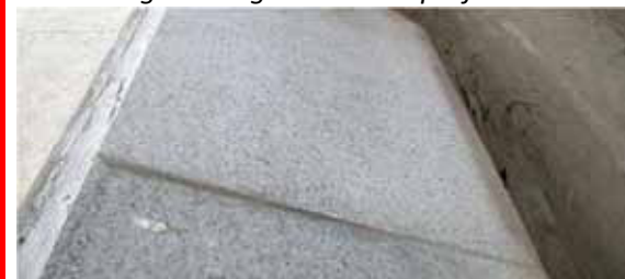
Nuove lastre in granito a superficie liscia e con le coste fresate a macchina
