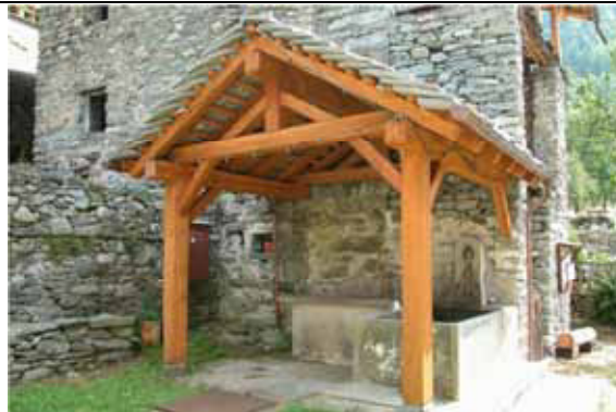
Lavatoio protetto da una nuova struttura con pilastri portanti e travatura del tetto in legno - Mollia, fraz. Goreto
