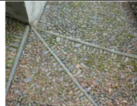
Via interna al paese - Guardabosone
