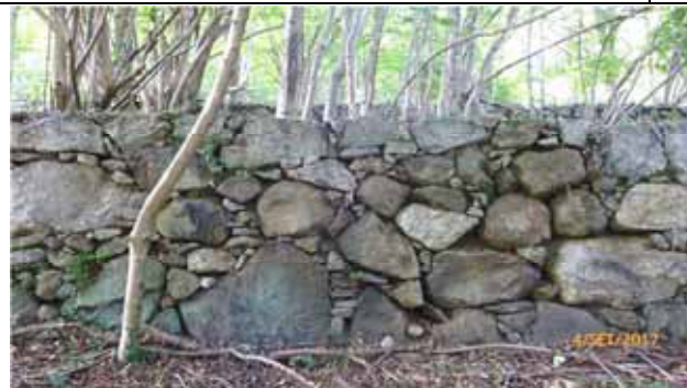
Muretto in gabbri con elementi di dimensioni molto varie, abilmente incastrati - Brugaro
