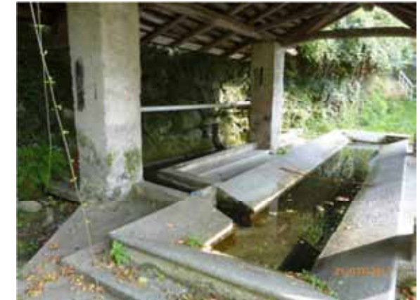
Due lunghe vasche parallele, collegate da breve canaletto, provviste di scivolo in pietra lungo tutto il perimetro e parzialmente incassate nel terreno: la lavandaie lavoravano in posizione inginocchiata
