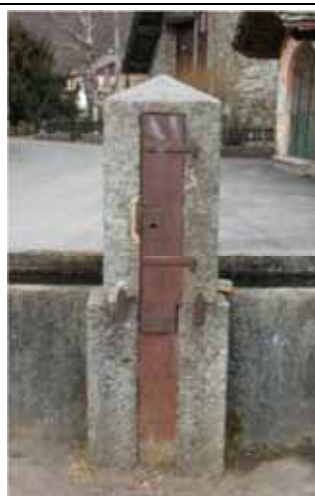
Lato posteriore di pilastrini, con vano contenente il tubo di adduzione dell'acqua, chiuso da sportello metallico (Scopa, loc. Valletto) o in legno (Scopa, loc. Villa)
