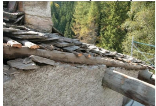
Correnti orizzontali costituiti da elementi mezzo-tondi, posati sui puntoni parallelamente alla linea di gronda, che sorreggono le lastre lapidee. Si nota come la pendenza della falda non influisce sulla pendenza delle piode, che risultano posate quasi in piano
