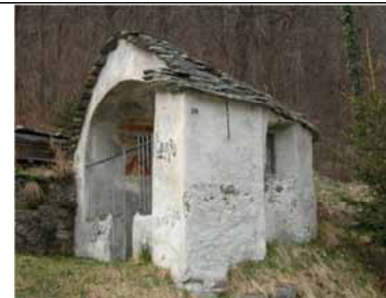
Cappella con abside semicircolare, muratura in pietrame intonacata, manto di copertura in pioda poggiante sull'estradosso della volta, vano interno affrescato - Scopello
