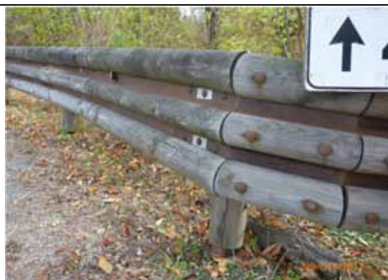
Barriera di sicurezza a fascia metallica con fissati sul lato frontale tre elementi paralleli a mezzo legno (vista fronte e retro) - strada Traversagna Grignasco-Boca
