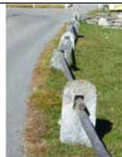
Recinzione tra strada e pascoli con lastre di pietra locale di forma irregolare infisse nel terreno, provviste di foro entro cui sono infilate le traverse in legno. L'altezza è contenuta e le traverse formano un'unica fila.
