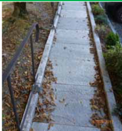
Rampa lastricata, con pietre di superficie e formato regolari e giunti ridotti, accessibile con carrozzina - Varallo
