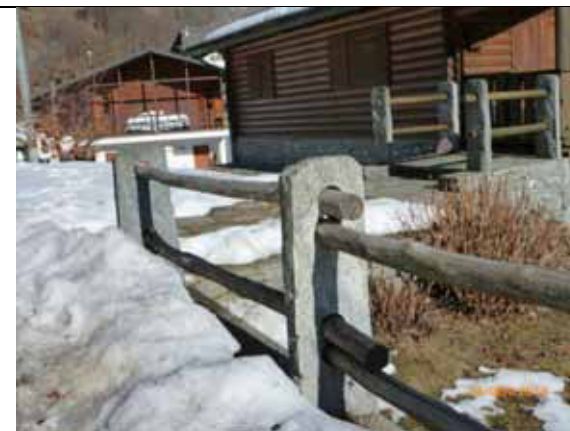
Recinzione ispirata alle tipologia tradizionale, con piedritti in pietra a superfici scabre e irregolari che sorreggono traverse in legno scortecciato e in tinta naturale - Rimasco
