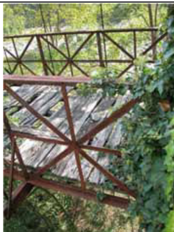
Fenomeni di degrado riguardanti gli elementi in ferro
