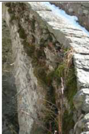
Sopra: degrado dovuto a vegetazione infestante, vicino e sulla struttura; erosione della malta nei giunti tra le pietre; fuoriuscita e caduta di elementi lapidei
