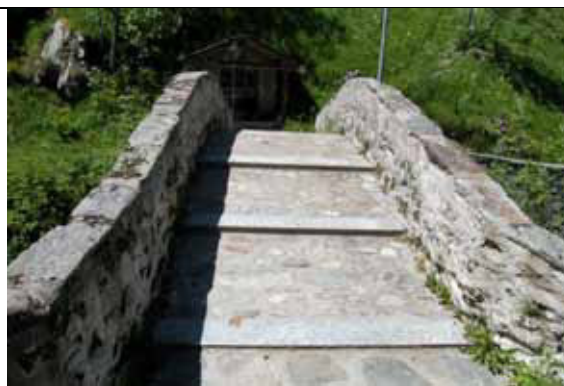
Recente rifacimento della pavimentazione eseguita con pietre annegate in abbondante malta cementizia e scalini costituiti da elementi con superficie liscia e costa rettificata
