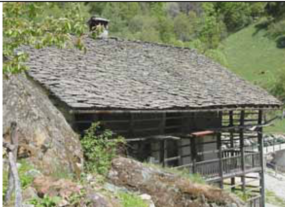
Copertura in piode locali - fraz. Pietre Marcie
