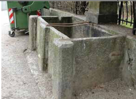
Fontana asciutta e abbandonata al degrado, che presenta danni meccanici con dislocazione degli elementi lapidei e frattura di una lastra (due foto sopra – anno 2003) - Scopello
