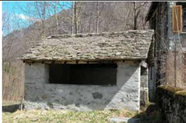
Tetto a capanna con manto in pioda e murature in pietra intonacata - Scopello, fraz. Chioso
