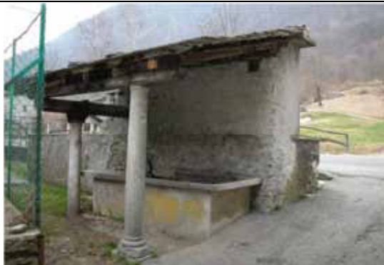
Lavatoio coperto da tettoia con manto in piode retta da due colonne e da un setto murario contro cui è addossata la retrostante fontana - Scopa, loc. Villa
