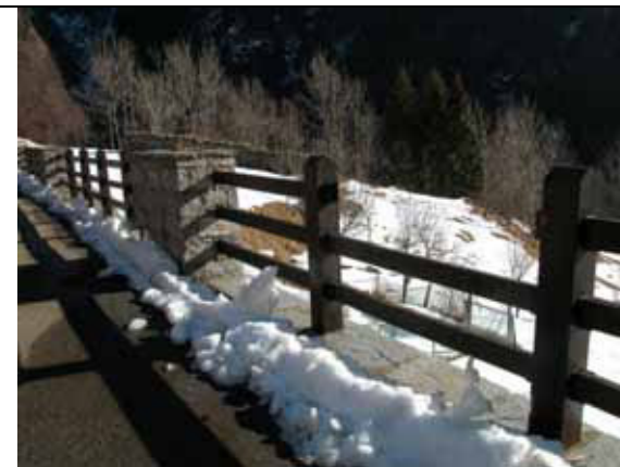
Parapetti in legno con elementi segati e rettificati, precocemente degradati e pilastri rivestiti in pietra - fraz. Priami
