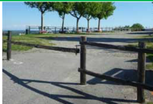
Recinzione con cancello a staccionata, di contenuto impatto visivo perchè particolarmente leggera ed essenziale (a differenza della staccionata a tre giri di traverse, visibile sullo sfondo) - Gattinara , Torre delle Castelle
