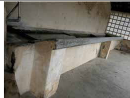
Lavatoio pubblico ancora utilizzato con lunga vasca in cemento divisa in più settori da setti interni - Quarona, fraz. Doccio
