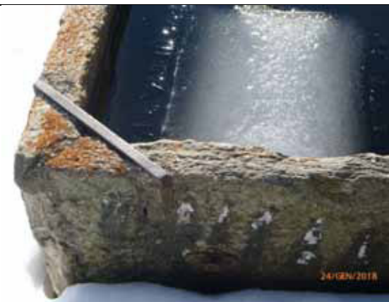
Fontana in pietra a lastre assemblate con giunzione a 45° e vincolo rinforzato da zanche metalliche - fraz. Campo Ragozzi
