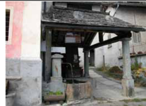
Due pilastri in pietra datati 1897 reggono la capriata del tetto che copre la fontana (1868) e il lavatoio (1879)- Piode, fraz. Piedimeggiana
