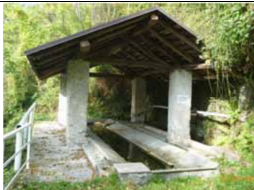
Lunga vasca solo parzialmente coperta da un tetto a due falde, ora in lamiera - Varallo
