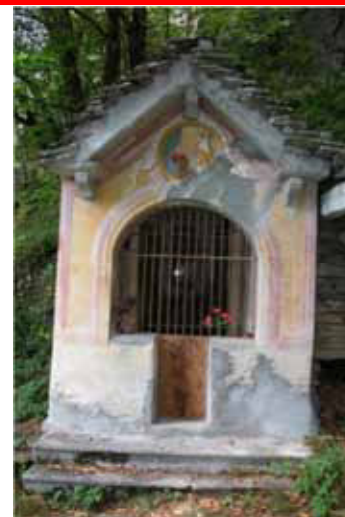
Risarciture d'intonaco eseguite con malta cementizia, anche sul timpano affrescato
