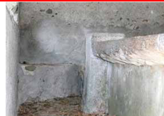
L'impiego di malta cementizia, sia come rinzafo sulle facciate esterne, sia come intonaco applicato nella parte bassa della parete, all'interno, ha accentuato i danni causati dall'umidità di risalita nel muro in pietra, impedendone la traspirazione. Sulla muratura si vede la zona di degrado a circa 1,5-2 m da terra, corrispondente alla fascia al di sopra delle parti in cemento
