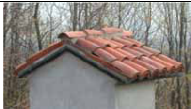
Tetto in nuovi coppi rif. cappelle foto a sinistra
