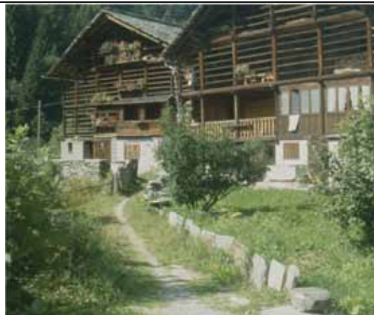
Lastre di pietra, infisse verticalmente nel terreno, delimitano il sentiero - frazione di Alagna (foto anni '60 del secolo scorso)
