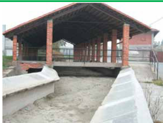
Gattinara: interventi di manutenzione straordinaria dell'imponente struttura del lavatoio pubblico, in parte scoperto (tratto centrale) e in parte coperto da fabbricati con tetto a due falde retto da pilastri in muratura di mattoni
