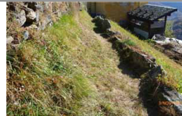
Pietre, non lavorate e semplicemente infisse nel terreno, tracciano il margine a valle di un sentiero - Rossa
