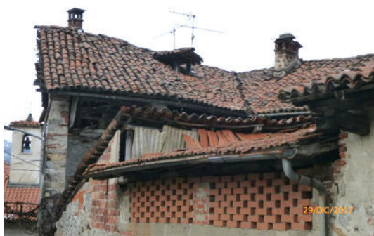
Manto in coppi e tamponamenti grigliati - Quarona
