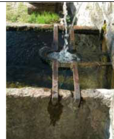
Struttura reggi secchio – Scopa, fraz. Ramello
