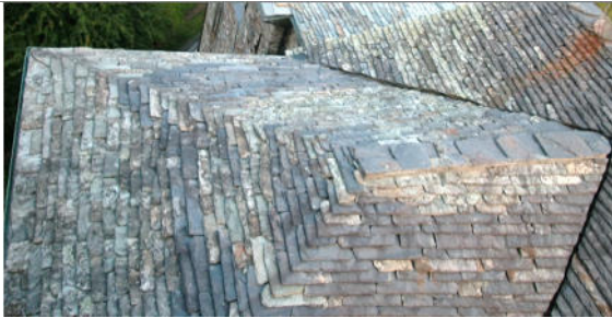
Cervarolo: manto con mescolanza di vecchie piode valsesiane di formato medio grande e di nuove beole
