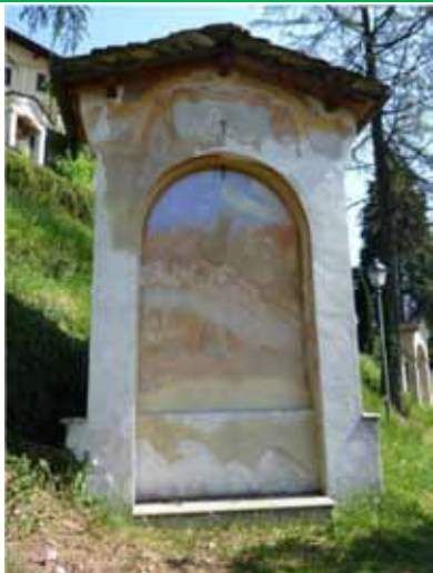
Risanamento e restauro conservativo delle cappelle della Via Crucis - Borgosesia, loc. Montrigone
