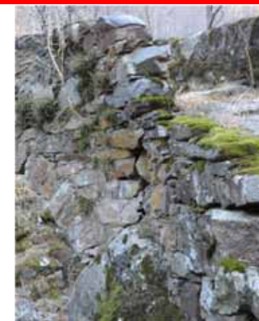
Ponte ad arco con spalle in muratura di pietrame sconnessa e pericolante (foto a destra), ripristinata ricostruendo parte del vecchio muro con abuso di malta cementizia (foto a sinistra). NON AMMESSO
