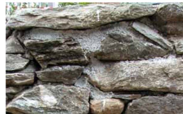
Muro con elementi lapidei allettati con impiego di malta cementizia, che risulta visibile nei giunti e sborda sulle pietre
