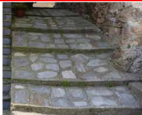
Lastre di dimensioni ridotte, annegate a raso nella malta del sottofondo e giunti stilati
