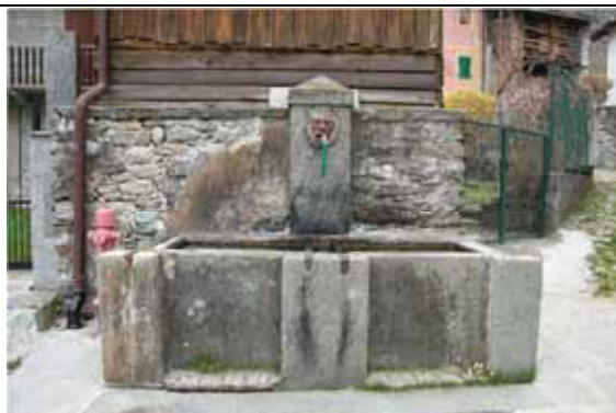
Vasca costituita più lastre, assemblate mediante incastro con sede ricavata negli appositi pilastri angolari e in quello posto a metà del lato lungo, essendo il fianco costituito da due lastre. Pilastro con bocca di erogazione sormontato da cuspide - Scopa, fraz. Scopetta
