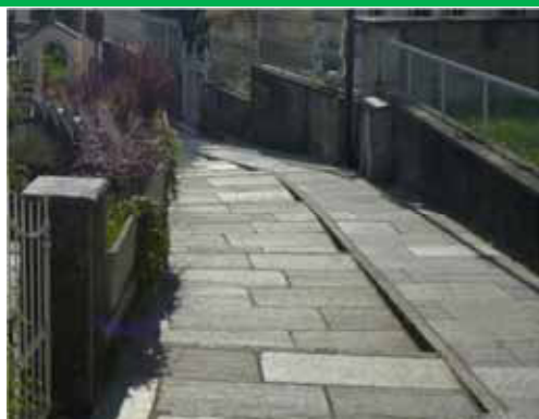
Strada lastricata a scalini con rampa laterale a pendenza costante per superamento delle barriere architettoniche - Cervatto
