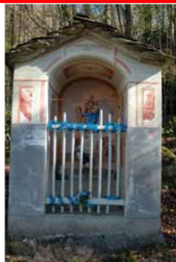
Rifacimento con malta cementizia dell'intonaco della parte inferiore dei pilastri di facciata
