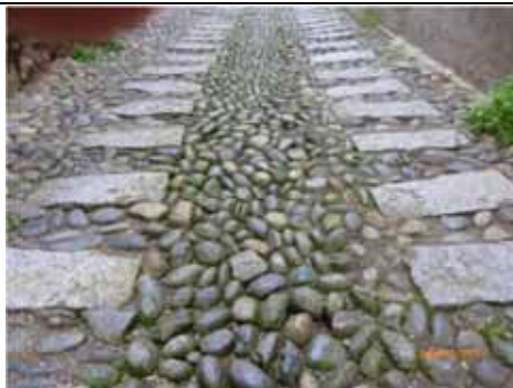
Soluzione insolita, con lastre segna-passo - Grignasco
