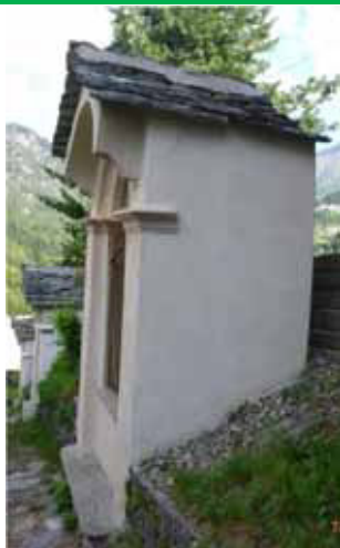
Rifacimento di intonaci ammalorati - Via Crucis, Cervatto
