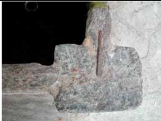
Giunzione tra le lastre che costituiscono in fianchi della vasca, con incastro in apposite scanalature ricavate nel pilastro angolare e rinforzo metallico - Piode, fraz. Piedimeggiana
