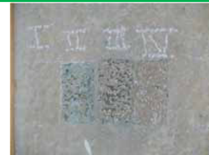
Esecuzione di stratigrafia preliminare agli interventi sulle superfici tinteggiate e/o decorate - Rimasco, fraz. Ferrate
