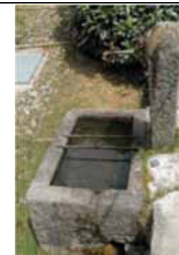
Fontana monolitica, rettangolare, con pilastrino di foggia semplice - Cravagliana, fraz. Brugarolo
