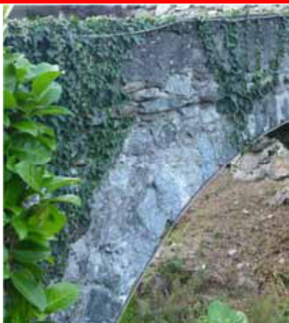
Sopra: interventi sulla muratura dei fianchi, delle spallette e dei parapetti, eseguiti con getto di calcestruzzo, o con impiego di intonaco cementizio. NON AMMESSI
