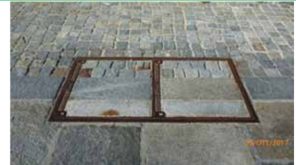
Tentativo volonteroso di mascherare i coperchi dei pozzetti integrandoli nella pavimentazione in pietra. (Con un telaio metallico di colore grigio, il risultato sarebbe stato più efficace) - Alagna
