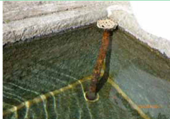
Pulitura della superficie del materiale lapideo, all'esterno e all'interno della vasca e ripresa 'discreta' delle sigillature in corrispondenza dei giunti tra le lastre, dal lato interno - Balmuccia
