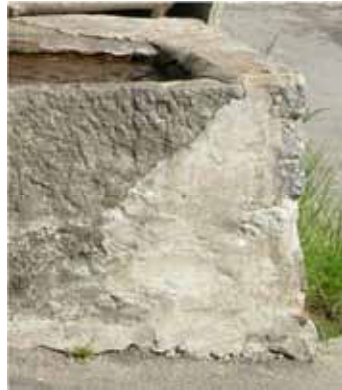
Grossolane e ridondanti risarciture eseguite con malta cementizia sul fianco esterno e sul bordo della vasca in pietra
