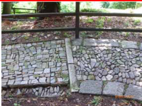
Risultato negativo di interventi recenti, differenti dall'originale e diversi anche tra loro, sia per il formato, il tipo e la pezzatura del materiale, sia per il sistema di posa
