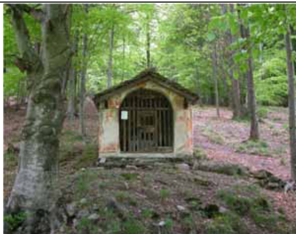
Preziosa cappella nel bosco, con tetto retto da struttura lignea e manto in pioda, con affreschi del XVI sec. anche all'esterno - Balmuccia, alpe Scalina
