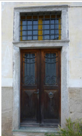
32- Morondo (Varallo): porta con piedritti, architrave e riquadro superiore in gneiss
