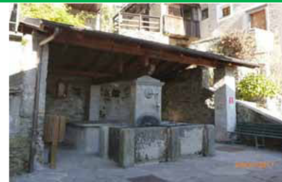
Rossa: manutenzione straordinaria della tettoia in piode e sistemazione dell'area circostante (gli interventi non hanno interessato le vasche in pietra)
