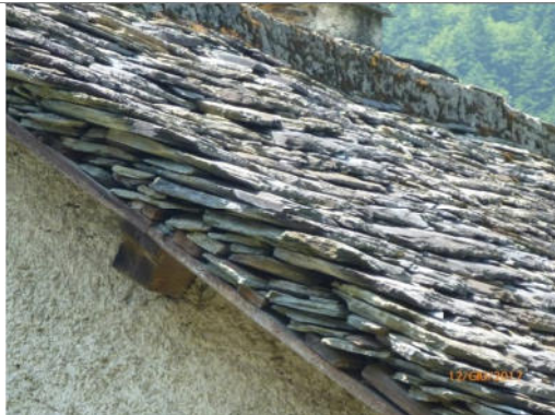
Vecchio tetto con impiego di piode locali di formato misto e dimensioni irregolari, posate senza corsi e con una fortissima sovrapposizione tra le lastre
