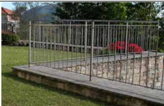
Sobrio e raffinato, seppure essenziale, il parapetto anticaduta che recinge una piccola area verde - Cellio, fraz. Agua
