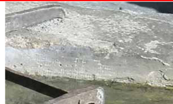
Impermeabilizzazione della superficie interna della vasca, probabilmente realizzata per impedire infiltrazioni di acqua attraverso microfessure della pietra. Intervento eseguito con prodotto applicato previa stesura preliminare di reticella mirata a migliorare l'aderenza e compensare eventuali deformazioni differenziate dovute a tensioni superficiali.
