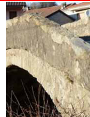
Sopra: interventi sulla muratura dei fianchi, delle spallette e dei parapetti, eseguiti con getto di calcestruzzo, o con impiego di intonaco cementizio. NON AMMESSI
