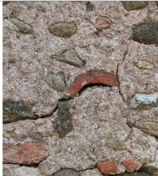
Malta idraulica ottenuta aggiungendo coccipesto a una calce aerea
