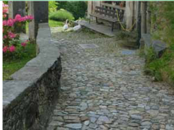
Ripristino di mulattiera a selciato, con impiego di scapoli di pietra locale – Varallo fraz. Morondo
