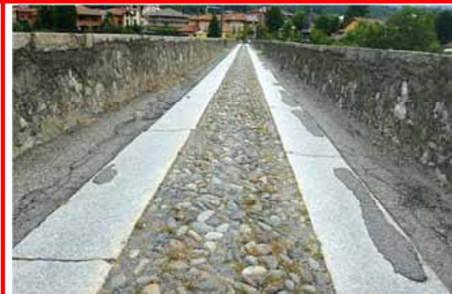
Tracce del vecchio manto di asfalto ormai logoro, visibili sulla pavimentazione originale in acciottolato e sulle belle lastre carraie
