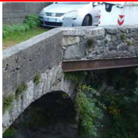
Sopra: interventi sulla muratura dei fianchi, delle spallette e dei parapetti, eseguiti con getto di calcestruzzo, o con impiego di intonaco cementizio. NON AMMESSI
