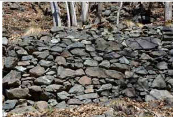
Muretto in pietre di formato irregolare e pezzatura mista di gneiss della serie kingizitica - Sabbia
