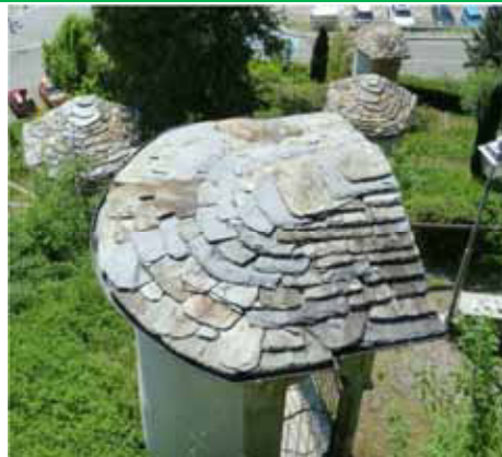
Manutenzione straordinaria alle coperture in pietra delle cappelle della Via Crucis - Borgosesia, loc. Montrigone
