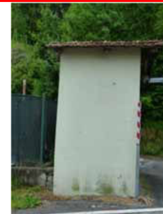
Tinteggiatura esterna con pittura acrilica non traspirante
