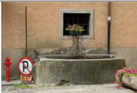
Vasca monolitica: il tubo di erogazione, fuoriesce dal muro dell'edificio al quale è addossata - Mollia centro
