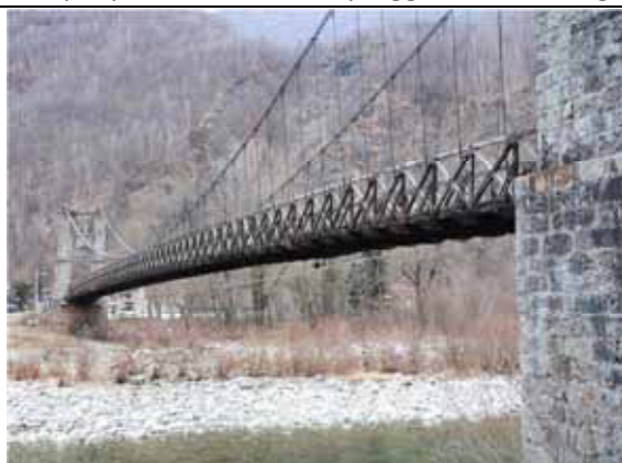
Ponte sospeso di Morca (Varallo)
