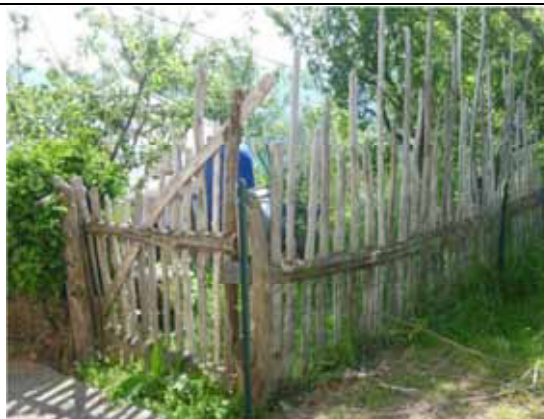
Recinzione di orto realizzata con due traverse orizzontali, ottenute da mezzi tronchi di sezione adeguata, alle quali è inchiodata una serie di sottili elementi verticali (semi tronchi e rami scortecciati) di altezza irregolare - Borgosesia, fraz. Ferruta
