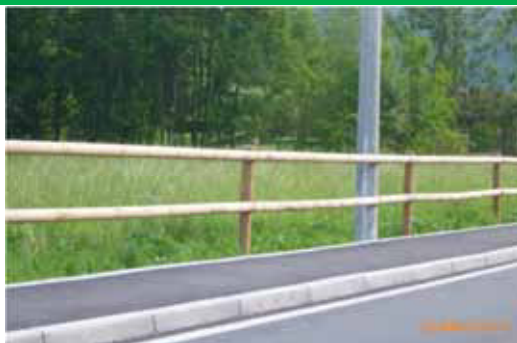
Montanti e traverse in legno di conifera a sezione circolare tornita. Le traverse, particolarmente lunghe in funzione del notevole interasse tra i pali, sono fissate esternamente ad essi - Varallo, località Crosa
