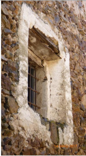
Muro in pietra a secco e cornice e strombatura esterna della finestra in tonachino (calce aerea e sabbia fine)
