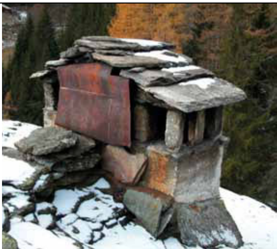
Vecchio tetto con manto in piode locali di pezzatura mista e forme irregolari, posate senza seguire dei corsi rettilinei - fraz. Rima
