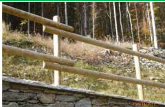
Montanti a sezione circolare e traverse a mezzo legno, fissate esternamente ai pali. Legno di conifera pre-trattato e lavorato in stabilimento; sullo sfondo: bosco di larici - Riva Valdobbia
