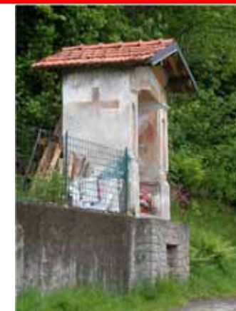
Nuovo tetto in tegole marsigliesi con frontalino in lamiera
