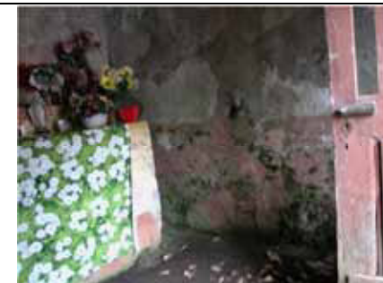
Patina biologica e degrado degli intonaci sulle pareti interne - Quarona, fraz. Doccio (p. privata)
