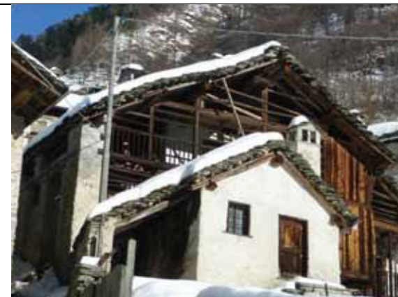
Casa con profondo loggiato ligneo sulla facciata principale esposta a Sud - fraz. Campo Ragozzi
