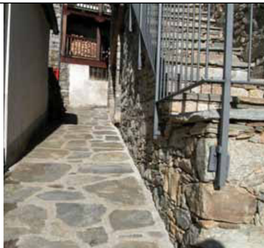
Pavimentazione con lastre di pietra di forma irregolare allettate in sovrabbondante malta cementizia - fraz. Priami
