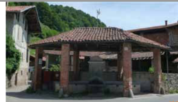
Originale pianta esagonale per la copertura in coppi retta da pilastri in mattoni che protegge la fontana e il lavatoio a vasca esagonale -Borgosesia, fraz. Caneto
