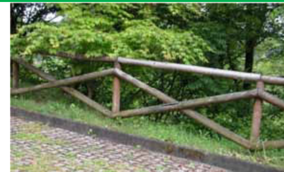
Staccionata in legno con traversa superiore orizzontale e traverse inferiori poste a croce di Sant'Andrea, realizzata con prodotti commerciali lavorati in stabilimento - Guardabosone
