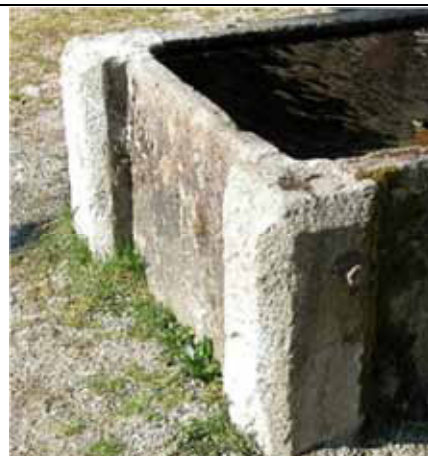
Assemblaggio delle lastre con incastro entro i pilastri angolari, trattenuti da tiranti metallici passanti - Scopa, fraz. Ramello
