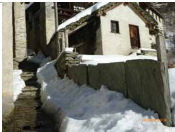
Mulattiera affiancata da recinzione in lastre di pietra infisse a coltello nel terreno - fraz. Campo Ragozzi
