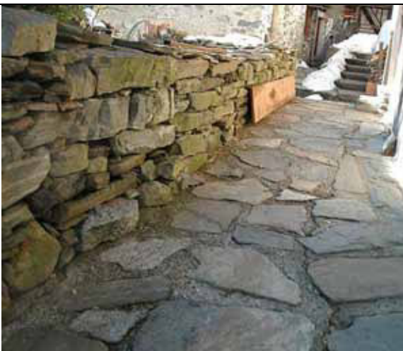
Muretto di pietre a secco e pavimentazione con lastre di pietra di forma irregolare posate con ampi giunti di malta - fraz. Priami
