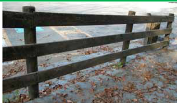
Staccionata in legno con pali a sezione circolare e traverse costituite da tavole segate e piallate, fissate esternamente ai pali, soggette a veloce degrado. Tipologia accettabile solo in area urbana - Scopello
