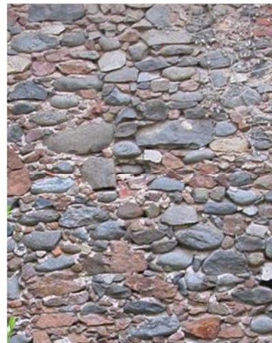
9- Guardabosone: muro in ciottoli e blocchi di varia natura litologica (gneiss, anfiboliti e vulcaniti) prelevati nel greto del torrente Strona
