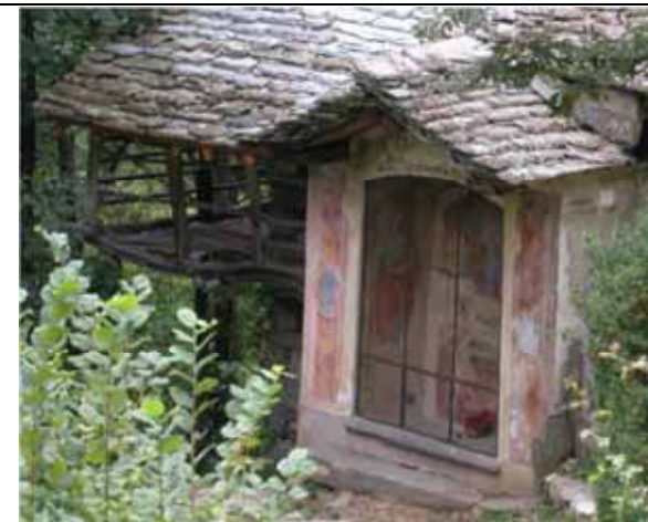
Edicola con tetto a capanna coperto in piode, costruita a ridosso della parete esterna di un fabbricato rustico. I dipinti si estendono sia all'interno della nicchia, che sulla facciata esterna - Mollia, fraz. Piana Fontana
