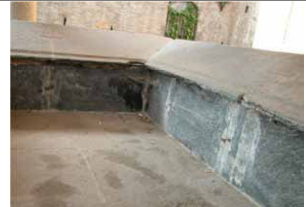
Vasca con fondo, pareti e scivolo in lastre di pietra. Graffe metalliche rinforzano il vincolo delle lastre in corrispondenza dei giunti - Grignasco
