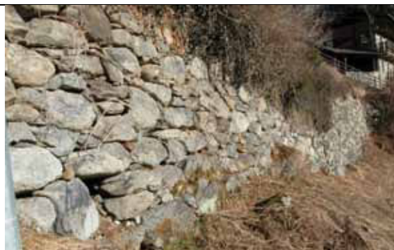
Vecchio muro di contenimento del terreno, realizzato con tecnica a secco (muro drenante) con pietre del luogo (gneiss)
