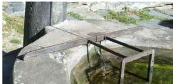
Impermeabilizzazione della superficie interna della vasca, probabilmente realizzata per impedire infiltrazioni di acqua attraverso microfessure della pietra. Intervento eseguito con prodotto applicato previa stesura preliminare di reticella mirata a migliorare l'aderenza e compensare eventuali deformazioni differenziate dovute a tensioni superficiali.
