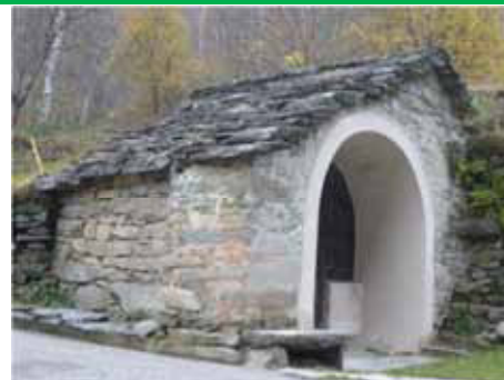
Intervento di risanamento da umidità di risalita mediante realizzazione di intercapedine ventilata lungo la base della parete laterale - Mollia
