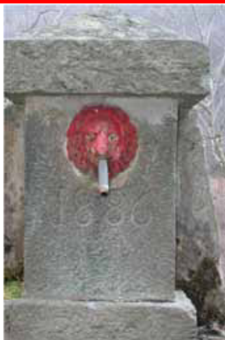
Coloritura impropria del rosone metallico della bocca di erogazione
