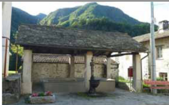
Lavatoio aperto, con tetto a capanna in piode retto da sei pilastri. L'area circostante la vasca è lastricata - Vocca, fraz. Isola
