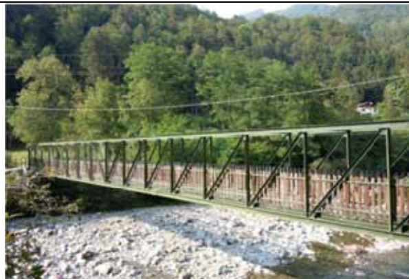
Ponte pedonale della Selva, sul Mastallone, relativamente recente, a trave reticolare (Cravagliana)
