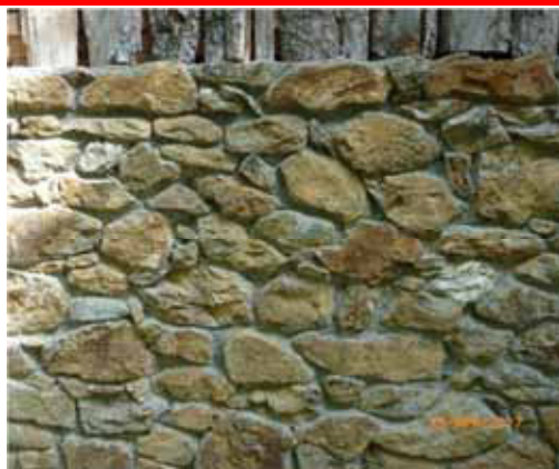
Tutti i giunti sono ripresi in malta cementizia a sottolivello, ma visibile, anche per la colorazione nettamente differente rispetto a quella delle pietre
