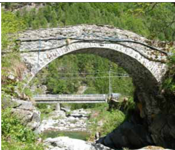
Ponte ad arco in pietra sul torrente Nonaj - Rima S. Giuseppe
