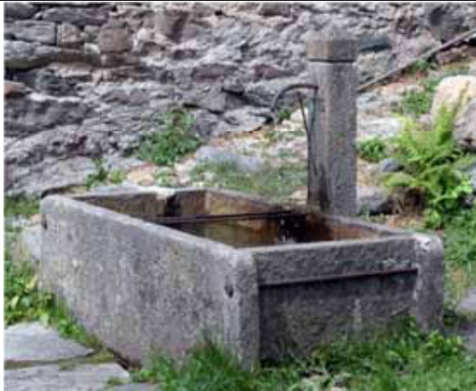
Assemblaggio delle lastre in pietra mediante inserimento attraverso appositi fori praticati nei lati lunghi, di tiranti metallici messi in tensione, posti all'esterno della vasca, così da ammorsare le lastre che costituiscono i lati corti - Mollia, fraz. Piana Fontana
