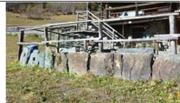
Lastre di pietra, infisse verticalmente lungo una staccionata, delimitano un orto. A sinistra si notano alcune lastre di recupero in serpentino, con foro, prima utilizzate per recinzioni miste legno pietra - Alagna, fraz. Piane
