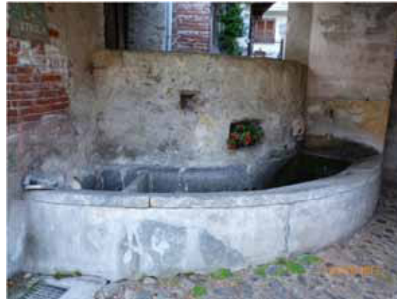
Originale lavatoio con vasca curva. Il setto divisorio, lo scivolo e i lati interni sono in pietra; il lato frontale esterno è intonacato. Pavimentazione in ciottoli del vicino Sesia
