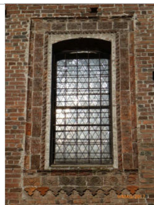
Muratura e apparato decorativo - Gattinara
