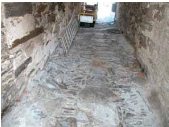
Vecchia pavimentazione in pietra locale di varia pezzatura (pietre verdi locali prese nel detrito di versante) - fraz. Rima
