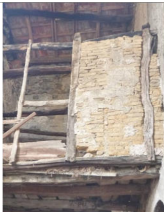
Antico tramezzo in mattoni crudi - Guardabosone
