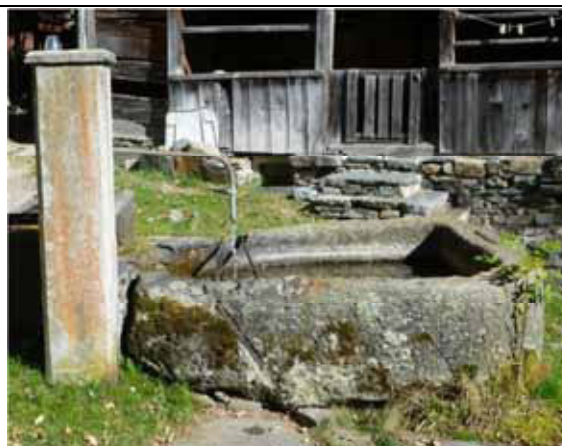
Antica fontana scavata in un masso di pietra con pilastro recente in cemento – Alagna, fraz. Goreto
