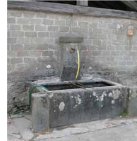
Fontana in cattive condizioni, a cui è stata addossata una brutta parete in blocchi di cemento, che ingloba il pilastro e ne cancella l'identità formale
