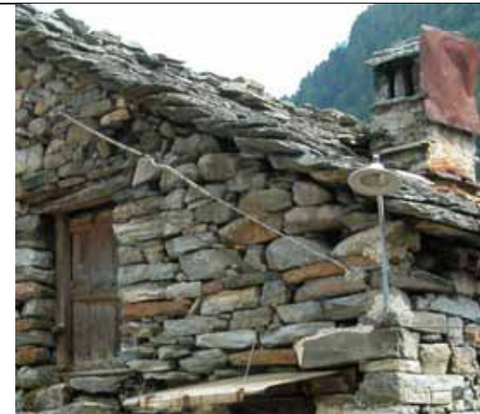
Baita con muratura completamente a secco e manto in piode locali
