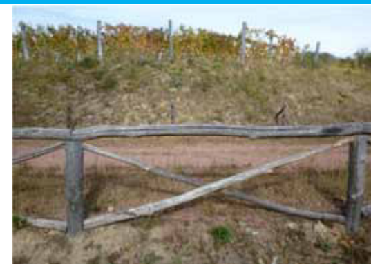
Recinzione rustica con disegno a croce di Sant'Andrea, in legno di castagno semplicemente scortecciato, a delimitazione di un vigneto - strada Traversagna tra Grignasco e Boca
