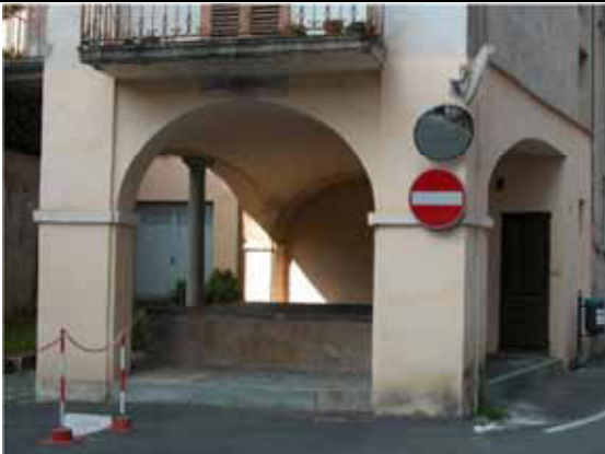
Lavatoio "Iannetti" del 1873, al piano terra di un edificio residenziale in centro paese - Grignasco
