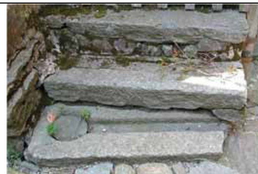
Bellissima pavimentazione in lastricato di pietra locale (gneiss) con sofisticata realizzazione di un efficace sistema di raccolta e convogliamento delle acque, eseguito con perfetta lavorazione della pietra per ottenere canali e scarichi. Ogni dettaglio rivela una accurata progettualità e una perfetta tecnica esecutiva (sopra e a sinistra) - Mollia fraz. Grampa
