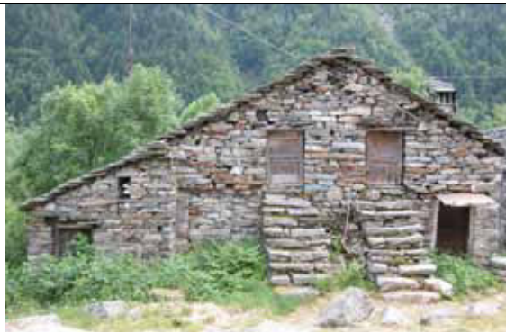
Grande baita organizzata in maniera speculare rispetto all'asse centrale, costruita in pietra a secco, con scale per accesso diretto al piano del sottotetto - fraz. Pian Morello (foto 2004)
