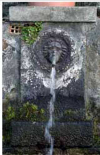
Crescita di vegetazione infestante, degrado biologico, efflorescenze saline e incrostazioni - Scopello e Scopa
