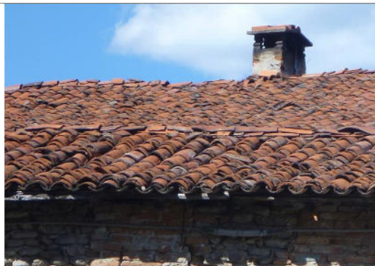
Manto in coppi - Vintebbio
