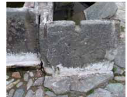
Sigillature eccessivamente evidenti dei giunti perimetrali alla base delle due vasche; imbrattatura delle superfici circostanti; forte fuori piombo del pilastro
