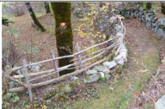
Recinzione che costeggia un sentiero realizzata raccogliendo pietre e tagliando rami disponibili in sito: i materiali e i colori sono esattamente quelli del paesaggio circostante - territorio del Comune di Mollia
