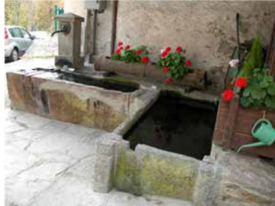
Vasca-lavatoio realizzata con lastre di pietra assemblate mediante incastro nei pilastrini angolari, collegata a fontana a bacino monolitico - Piode, fraz. Piedimeggiana
