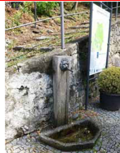
Risarciture e rinzaffo di malta su vecchio muro a secco
