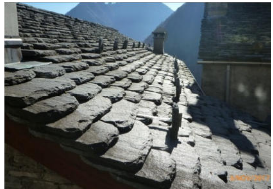
Rossa: nuovo manto in beole di dimensione costante posate a filari rettilinei e perfettamente regolari e con ridotto sormonto tra gli elementi
