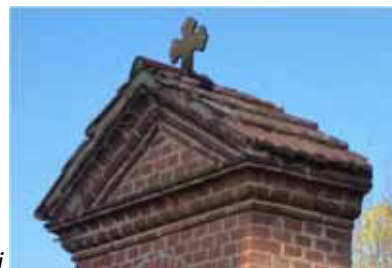
Tetto in marsigliesi riferimento cappelletta foto a destra
