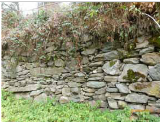
Muretto in gneiss anfibolitico, di pezzatura molto variabile – Mollia sopra al cimitero
