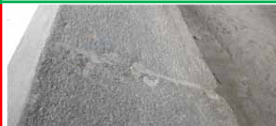
Lastre originali in gneiss con superficie scabra
