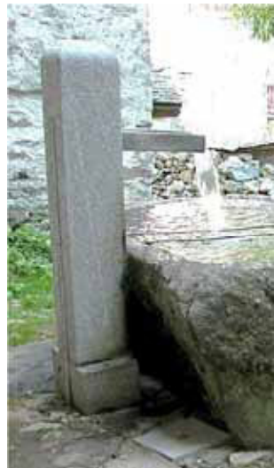
Grossolane e ridondanti risarciture eseguite con malta cementizia sul fianco esterno e sul bordo della vasca in pietra
