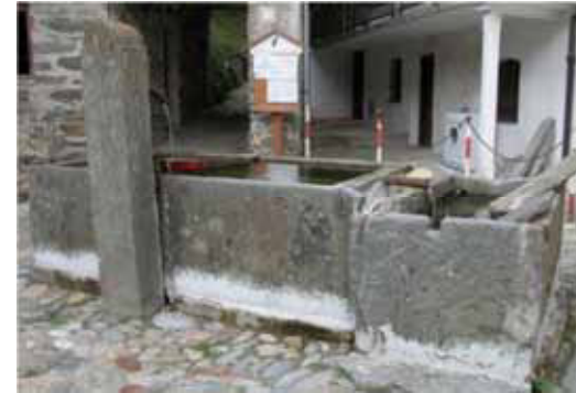
Sigillature eccessivamente evidenti dei giunti perimetrali alla base delle due vasche; imbrattatura delle superfici circostanti; forte fuori piombo del pilastro
