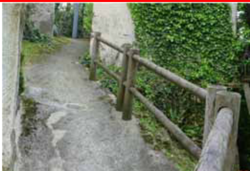
Legno di conifera stabilizzato in autoclave, con traverse infilate nelle sedi all'interno dei pali. La pavimentazione in cemento e la staccionata industriale, troppo regolare e di colore omogeneo, non giovano alla valorizzazione dell'ambiente rurale
