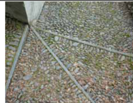
Via interna al paese - Guardabosone
