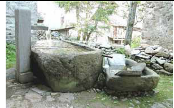
Immagine in cui è molto evidente il sistema idrico previsto per queste soluzioni: colonnina con tubo e bocca/canale di erogazione, fontana superiore con scarico di troppo pieno che alimenta la vasca inferiore ad uso lavatoio. Nel caso della foto la colonnina che contiene il tubo di adduzione è frutto di un intervento recente - Campertogno, fraz. Otr
