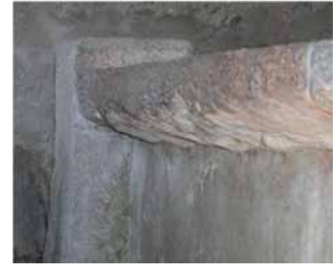
Nell'ottica dell'economia di tempo e fatica, la pietra veniva lavorata con cura solo nelle superfici a vista e nelle parti funzionali, come lo scivolo su cui fregare i panni e il pilastro angolare, lasciando più grezze le altre superfici, come il lato inferiore della lastra posta a scivolo (sopra e a destra) – Scopello, fraz. Chioso
