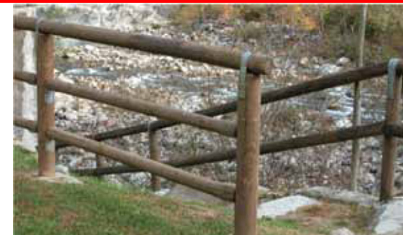
Tipologia di staccionata con montaggio che si avvale di fasce e mensole metalliche per l'unione e il fissaggio degli elementi in legno torniti a sezione regolare e superficie liscia
