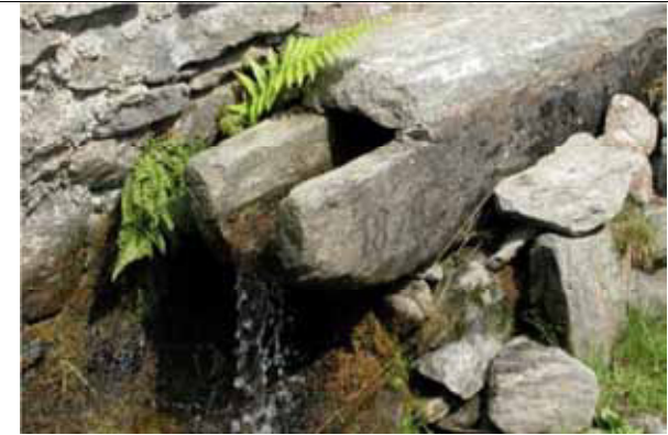
Abbeveratoio a canale basso e allungato: da un lato è addossato a un muretto, mentre l'altro lato è realizzato con lastre di pietra messe di taglio. Dettaglio della pietra scavata (una sorta di canale) per l'erogazione dell'acqua, datata 1878 - Mollia fraz. Piana Fontana (foto sopra e a lato – anno 2003)
