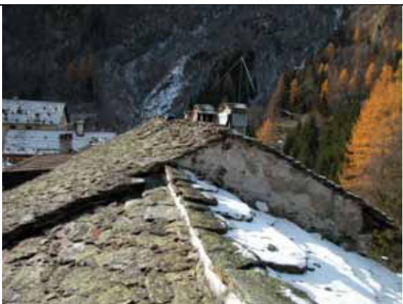
Vecchio tetto con manto in piode locali di pezzatura mista e forme irregolari, posate senza seguire dei corsi rettilinei - fraz. Rima
