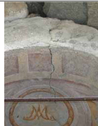
Fessurazione in chiave dell'arco con separazione di due porzioni di muratura che risultano leggermente traslate una rispetto all'altra - Balmuccia, cappelletta loc. Dinelli
