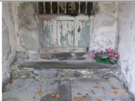
Pavimento interno in lastricato di beola - Scopa
