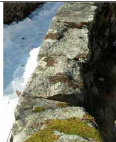
Sopra: degrado dovuto a vegetazione infestante, vicino e sulla struttura; erosione della malta nei giunti tra le pietre; fuoriuscita e caduta di elementi lapidei
