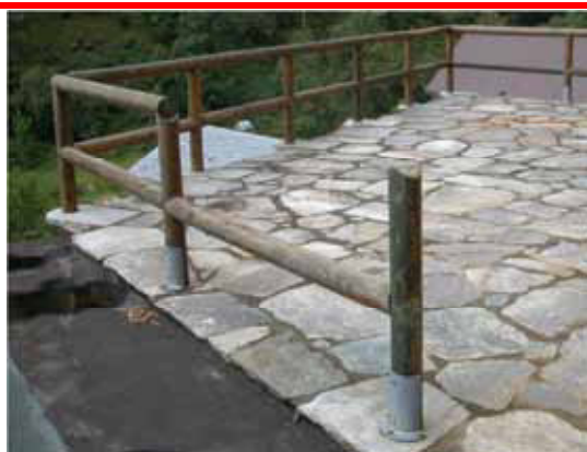
Legname tornito e fissaggio a terra mediante sede metallica a bicchiere
