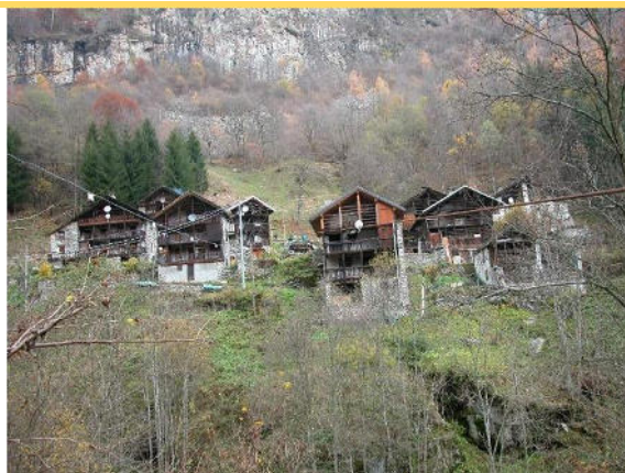
Rimasco, fraz. Ca' di Zelle, 985 m s.l.m.: iso-orientamento delle facciate provviste di loggiate in legno rivolto a Sud per l'essiccazione di foraggi e cereali
