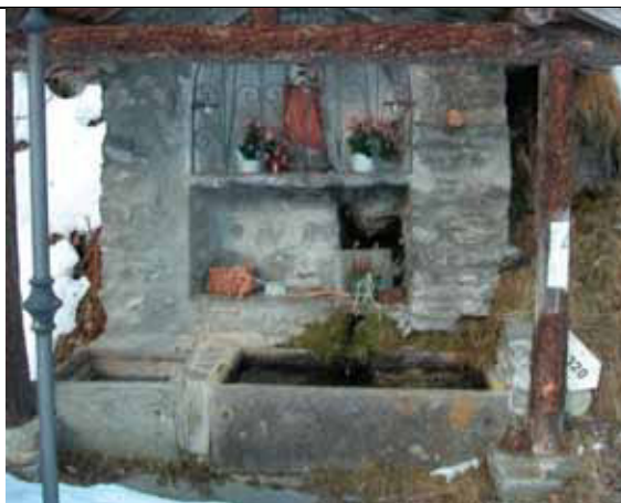
Doppia fontana in pietra (gneiss locale) di tipologia a lastre assemblate posizionata davanti ad una cappelletta - San Giuseppe
