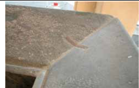
Raffinata esecuzione dello scivolo, con giunto a 45 gradi tra le lastre rinforzato da zanca metallica - Grignasco, lavatoio "IANNETTI"
