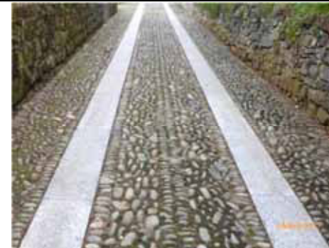
Con lastre carraie per veicoli – Grignasco fraz. Ara
