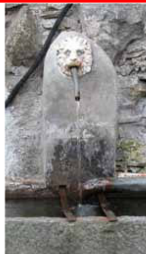
Coloritura impropria del rosone metallico della bocca di erogazione
