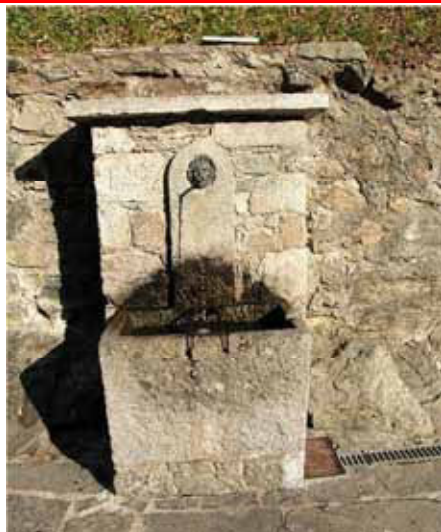
Muri in pietra con malta di allettamento
