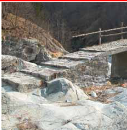
Sopra: interventi di ripristino o nuova esecuzione di pavimentazioni e murature parapetti, eseguite con sovrabbondante allettamento in malta cementizia, o con pastina di cemento, e/o impiegando elementi lapidei non adatti (lastre in formati regolari e superfici lisce, coste rettificata a macchina, spigoli vivi). NON AMMESSI
