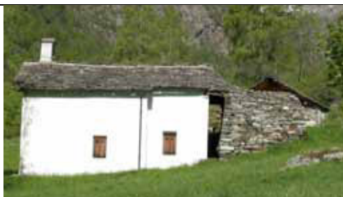
Massiciata in pietra a forma di cuneo, costruita sul retro della chiesa di S. Nicolao per proteggerla dall'urto di eventuali valanghe, deviando ai lati la massa della neve. Come si vede nella foto a destra la forma è simile a quella delle pile dei ponti in muratura, progettate per resistere all'urto della corrente - fraz. Rima
