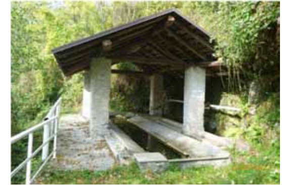
Lavatoio vicino al torrente Mastallone, accanto a un'antica roggia. Il tetto, a due falde, attualmente coperto in lamiera, protegge solo parzialmente le due vasche - Varallo, al ponte del Busso (foto sopra e sotto)
