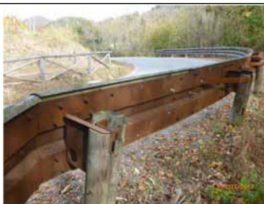
Barriera di sicurezza a fascia metallica con fissati sul lato frontale tre elementi paralleli a mezzo legno (vista fronte e retro) - strada Traversagna Grignasco-Boca
