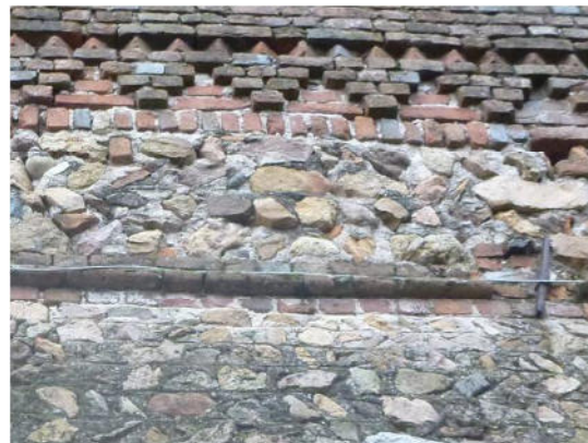
21- Lozzolo: alternanza di elementi in vulcaniti (porfidi e piroclastiti) e laterizi
