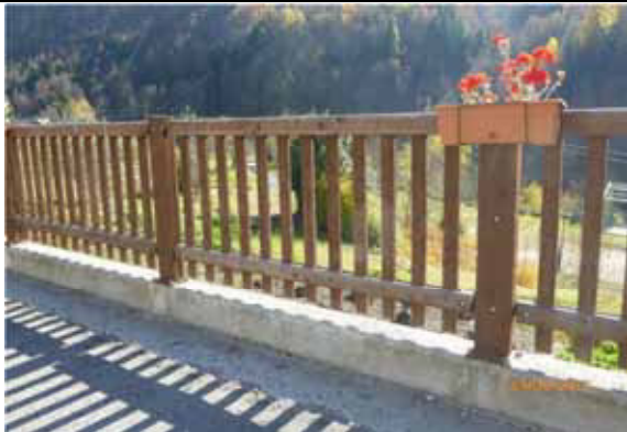
Barriera pedonale a steccato - Boccioleto (sopra e dettaglio foto a destra)
