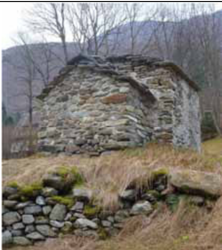
Cappella costruita con muratura in pietrame, copertura in pioda e abside rettangolare - Scopa (3 foto di questa riga)
