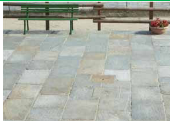
Nuova pavimentazione a lastricato, con lastre di formato regolare, superficie scabra, giunti sottili, coperchi dei pozzetti realizzati nella stessa pietra usata per il pavimento - Cervatto
