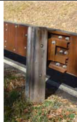
Barriera di sicurezza a fascia singola di acciaio mascherato da due tavole sovrapposte - Rossa (sopra e dettaglio foto a sinistra)
