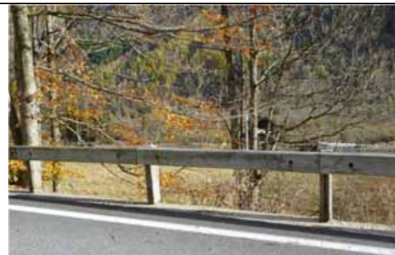
Barriera di sicurezza stradale a fascia singola, in acciaio completamente rivestito in tavole di legno - Riva Valdobbia
