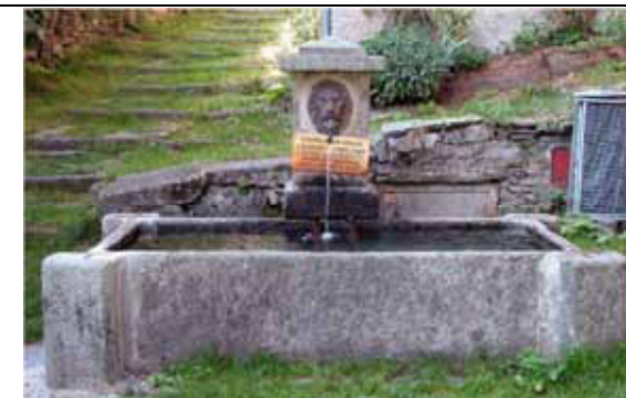
Le quattro lastre che costituiscono i fianchi della vasca si incassano in una apposita sede all'interno dei pilastri angolari, posizionati in forte aggetto. Pilastro per l'erogazione posto a metà del lato lungo - Boccioleto, fraz. Palancato
