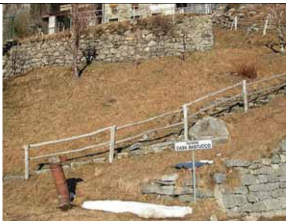
Muri a secco, sentiero e staccionata in legnodi tipo tradizionale - Ca' Bastucco
