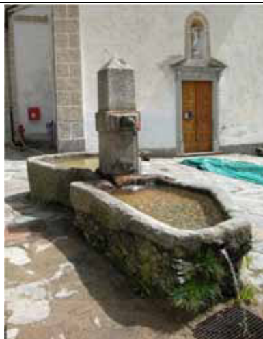
Fontana a due bacini monolitici contrapposti rispetto al pilastrino centrale con doppia erogazione. Scarico dal troppo pieno – Rima S. Giuseppe, fraz. Rima
