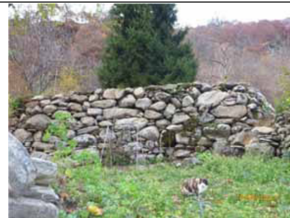
Muretto in gneiss con materiale alluvionale, tondeggiante, non lavorato - Mollia verso Piana Fontana
