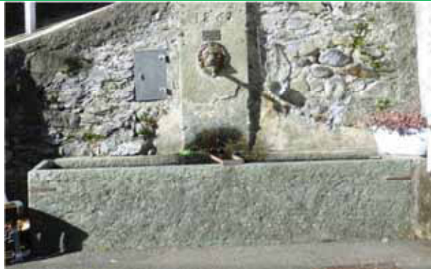
Pulitura della superficie del materiale lapideo, all'esterno e all'interno della vasca e ripresa 'discreta' delle sigillature in corrispondenza dei giunti tra le lastre, dal lato interno - Balmuccia
