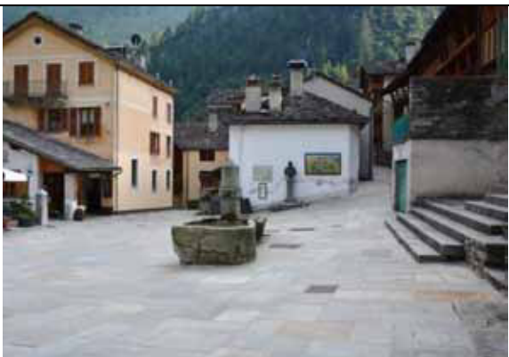
Piazza pavimentata con nuove lastre di formato regolare e coste rettificata di pietra non locale (beola), posate a correre, che la rendono simile ad altre piazze di località situate in territori paesaggisticamente differenti (Varallo, Borgosesia) - fraz. Rima
