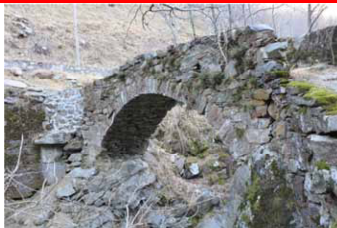
Ponte ad arco con spalle in muratura di pietrame sconnessa e pericolante (foto a destra), ripristinata ricostruendo parte del vecchio muro con abuso di malta cementizia (foto a sinistra). NON AMMESSO
