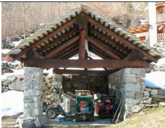
Recente copertura con struttura in legno e manto in beole del lavatoio comunale - fraz. Priami
