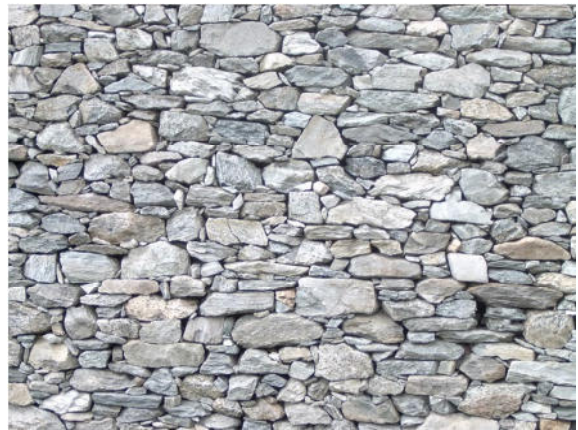
7- Pian dell'Erba (Campertogno): muro realizzato in elementi eterogenei grossolanamente squadrati di gneiss massiccio
