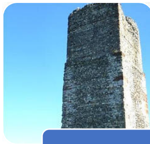
antica torre restaurata
