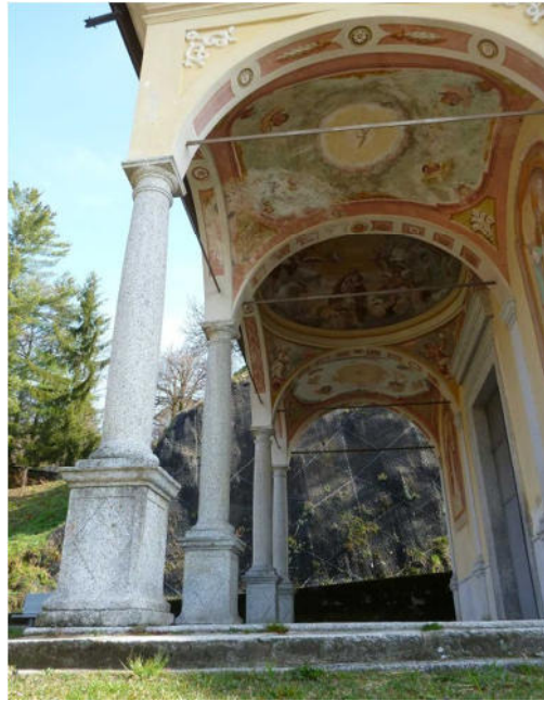
25- Carega (Cellio): portico della chiesa di San Matteo: basi, colonne, capitelli in granito
