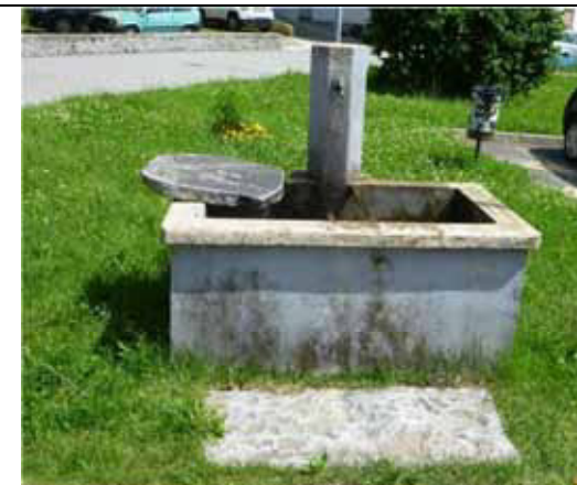
Situazione opposta: predisposizione di lastra in pietra, per trasformare in lavatoio la fontana con vasca in cemento - Borgosesia, fraz. Caneto
