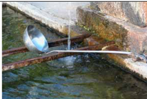
Bacchette in ferro posizionate al di sotto della bocca di erogazione per appoggio del secchio e tipico mestolo appeso alla fontana disponibile per bere – Pila
