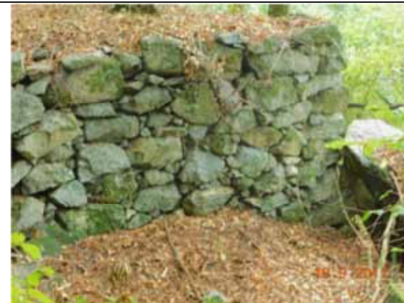
Muretto in granito, con elementi di scarto di cava, di forma poliedrica - Quarona
