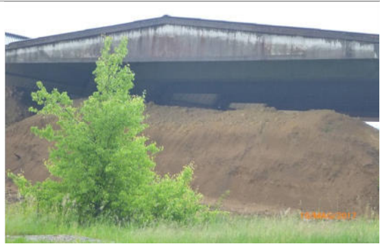
Capannone con materiale cavato- Lozzolo
