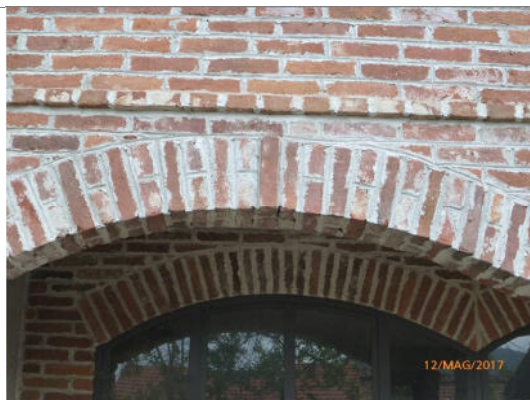
Arco in laterizi - Guardabosone
