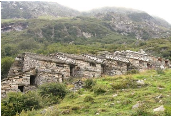
I fabbricati rurali dall'interessante disposizione a schiera dell'alpe Lanciole di Sotto, completamente costruiti in gneiss del luogo (murature e copertura)
