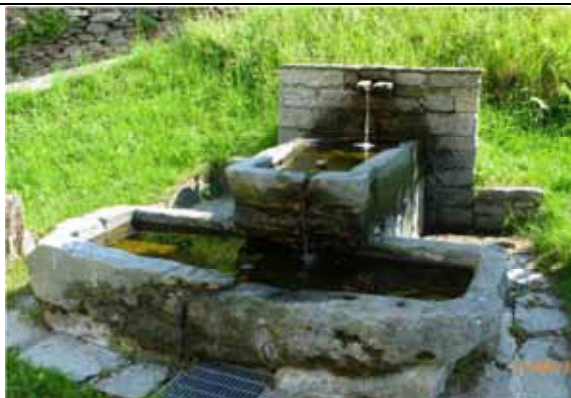
Due bacini monolitici, posti ad altezze diverse, per la fontana e l'abbeveratoio datato 1621 - Rimella, fraz. Chiesa
