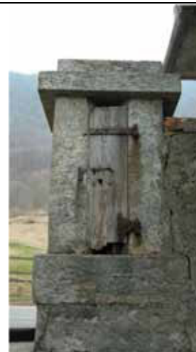
Lato posteriore di pilastrini, con vano contenente il tubo di adduzione dell'acqua, chiuso da sportello metallico (Scopa, loc. Valletto) o in legno (Scopa, loc. Villa)
