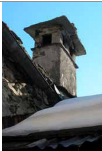
Vecchio comignolo con il fusto in muratura con intonaco grezzo e la copertura in lastre di pietra - fraz. Priami
