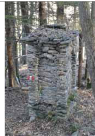
Pilone votivo in pietra a vista, non intonacato (incompiuto), con piccola nicchia ad arco su ognuna delle quattro facciate - Varallo, fraz. Parone
