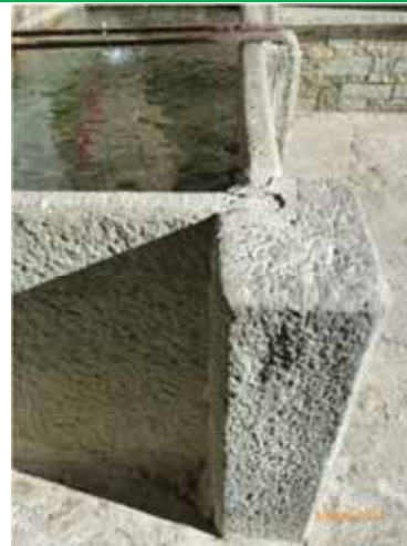
Restauro della fontana con pulitura della pietra, rimozione di alghe e licheni, rimozione di incrostazioni e depositi salini, revisione giunti e sigillature, sistemazione dell'area circostante - Rossa
