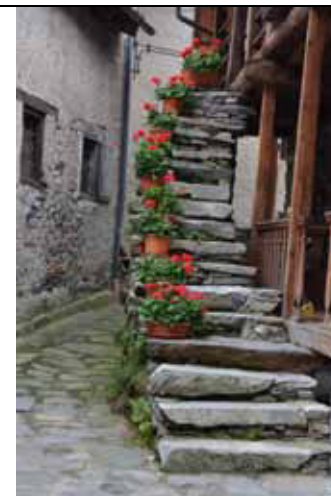
Vecchia scala con gradini monolitici di pietra locale (gneiss) - fraz. Rima
