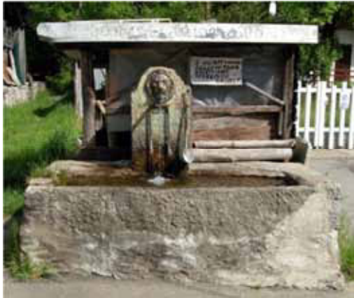
Grossolane e ridondanti risarciture eseguite con malta cementizia sul fianco esterno e sul bordo della vasca in pietra
