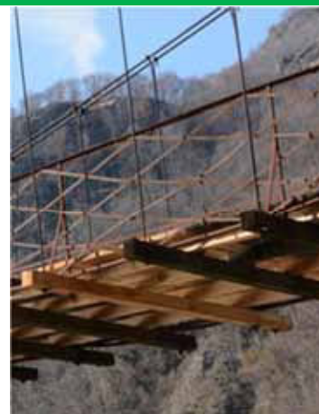
Interventi di manutenzione agli elementi in ferro e al tavolato in legno. AMMESSI
