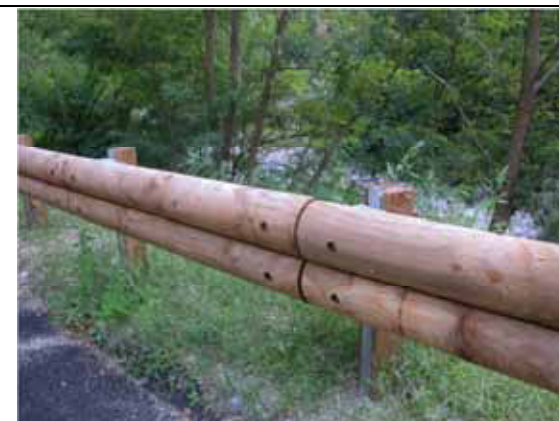
Barriera di sicurezza in acciaio colore argenteo, mascherato solo sul lato frontale da elementi a mezzo legno - Fobello
