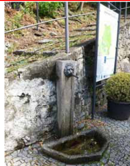
Risarciture e rinzafo di malta su vecchio muro a secco
