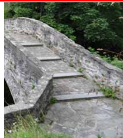
Sopra: interventi di ripristino o nuova esecuzione di pavimentazioni e murature parapetti, eseguite con sovrabbondante allettamento in malta cementizia, o con pastina di cemento, e/o impiegando elementi lapidei non adatti (lastre in formati regolari e superfici lisce, coste rettificata a macchina, spigoli vivi). NON AMMESSI
