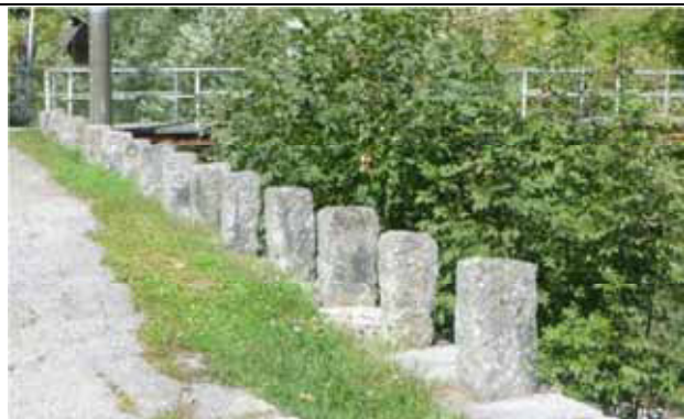
Serie regolare di paracarri posti a delimitare il ciglio stradale in corrispondenza di un precipizio - Cravagliana, fraz. Valbella Inferiore
