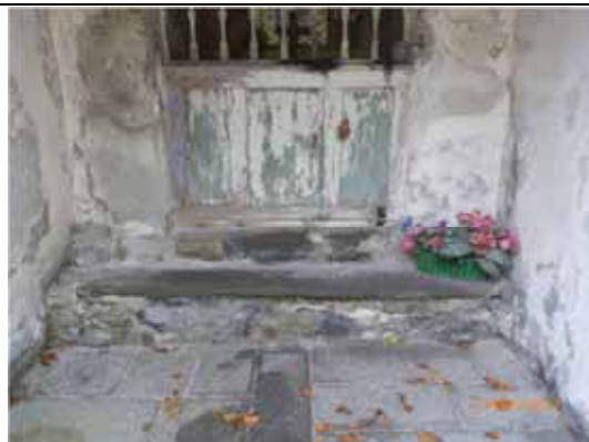
Pavimento interno in lastricato di beola - Scopa
