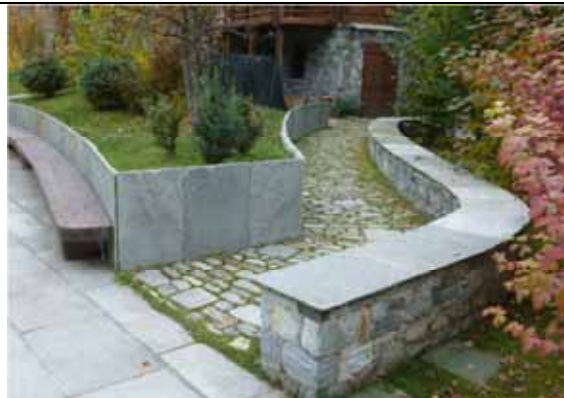
Situazione simile a quella della foto a sinistra, ma con lastre di formato e dimensioni regolari e costanti
