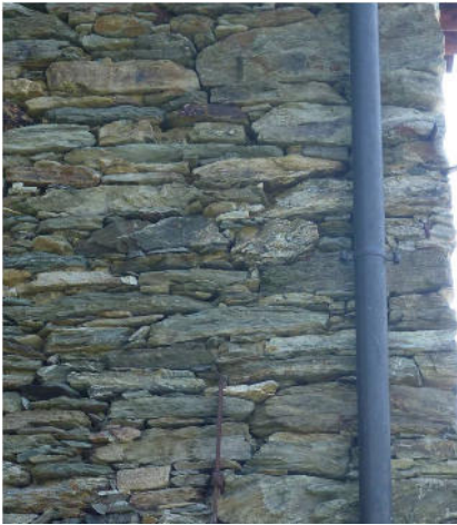
14- Sella (Rimella): muro in micascisto gneissico con elementi cantonali selezionati
