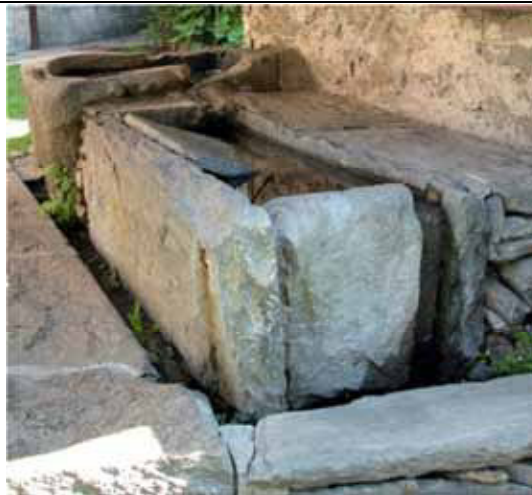
Fontana a bacino monolitico e lavatoio realizzato con assemblaggio di lastre di pietra di forte spessore. Particolarmente accurata la realizzazione di canaletta perimetrale per la raccolta dell'acqua che fuoriesce dalle vasche – Mollia, fraz. Casacce
