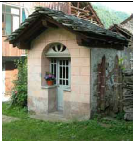
Cappella con tetto a capanna in pioda retto da struttura lignea e vano interno protetto da serramenti in legno - Campertogno, fraz. Otra
