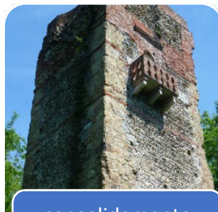
consolidamento statico e restauro paramenti murari della torre
