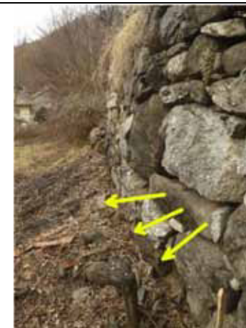
Fuoriuscita, con inizio di espulsione, di una pietra
