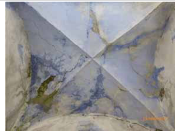
Piccolo vano accessibile a pianta quadrata, coperto da volta a crociera, realizzata in pietrame e intonacata - Scopa
