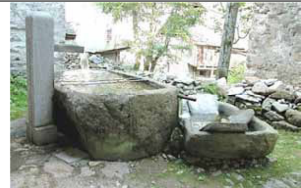
Immagine in cui è molto evidente il sistema idrico previsto per queste soluzioni: colonnina con tubo e bocca/canale di erogazione, fontana superiore con scarico di troppo pieno che alimenta la vasca inferiore ad uso lavatoio. Nel caso della foto la colonnina che contiene il tubo di adduzione è frutto di un intervento recente - Campertogno, fraz. Otr
