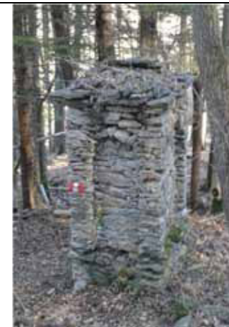
Pilone votivo in pietra a vista, non intonacato (incompiuto), con piccola nicchia ad arco su ognuna delle quattro facciate - Varallo, fraz. Parone
