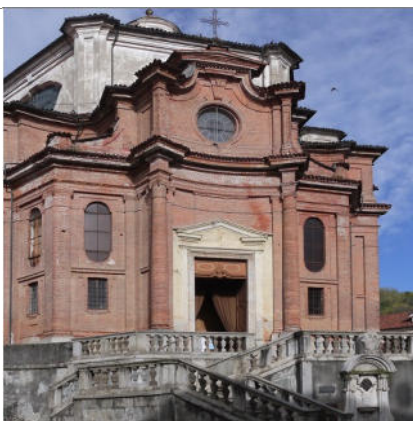
Mattone a vista in edifici monumentali - Grignasco
