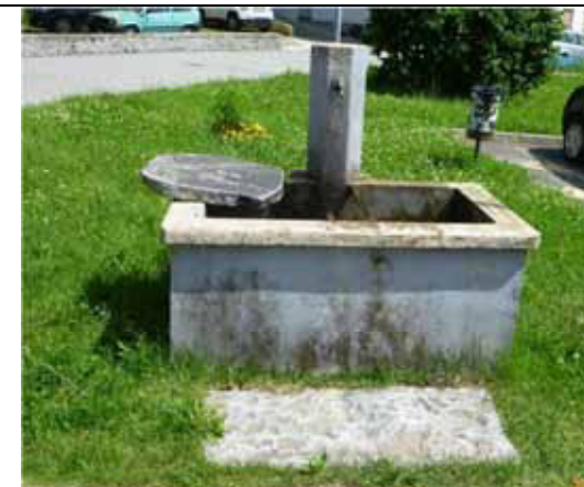
Situazione opposta: predisposizione di lastra in pietra, per trasformare in lavatoio la fontana con vasca in cemento - Borgosesia, fraz. Caneto
