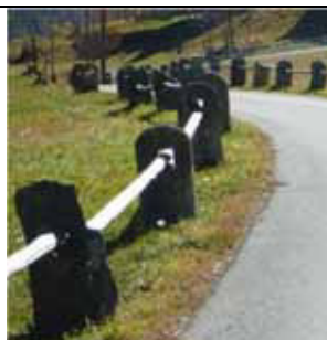
Recinzione tra strada e pascoli con lastre di pietra locale di forma irregolare infisse nel terreno, provviste di foro entro cui sono infilate le traverse in legno. L'altezza è contenuta e le traverse formano un'unica fila.
