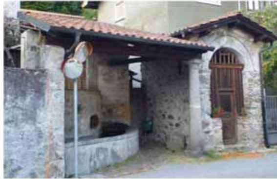
Lavatoio con vasca curva, coperto da tetto a una falda, oggetto di recente rifacimento, situato accanto a una cappelletta lungo la via di accesso al paese - Varallo fraz. Locarno (foto sopra e sotto)
