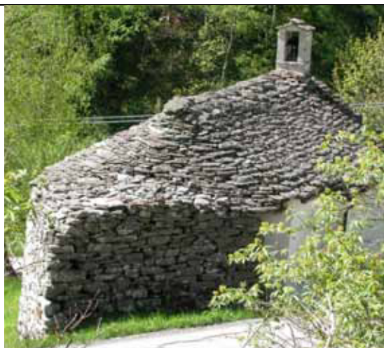
Massiciata in pietra a forma di cuneo, costruita sul retro della chiesa di S. Nicolao per proteggerla dall'urto di eventuali valanghe, deviando ai lati la massa della neve. Come si vede nella foto a destra la forma è simile a quella delle pile dei ponti in muratura, progettate per resistere all'urto della corrente - fraz. Rima
