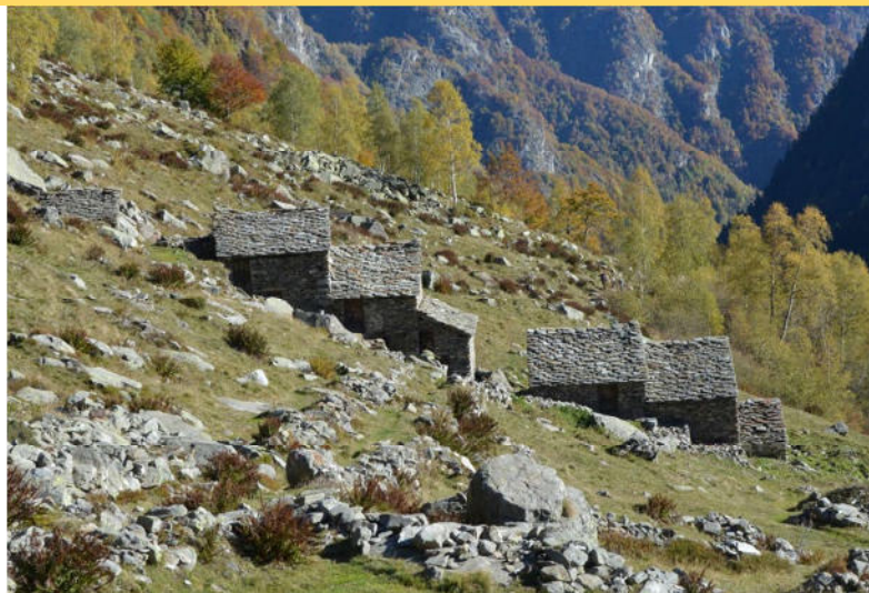
Val Gronda, Alpe Straiga 1480 m s.l.m. Baite costruite a schiera con direttrice la linea di pendio: economia costruttiva (ogni edificio fa da contrafforte a quello più a monte) e risparmio di materiali (condividendo un muro portante). Inoltre sfruttamento del massimo soleggiamento, poichè nessun fabbricato proietta ombra su quello limitrofo
