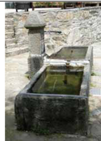
Vasche gemelle affiancate, costituite da più lastre, e pilastrino datato 1882 - Rimasco, fraz. Priami
