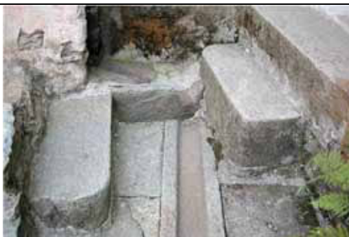
Bellissima pavimentazione in lastricato di pietra locale (gneiss) con sofisticata realizzazione di un efficace sistema di raccolta e convogliamento delle acque, eseguito con perfetta lavorazione della pietra per ottenere canali e scarichi. Ogni dettaglio rivela una accurata progettualità e una perfetta tecnica esecutiva (sopra e a sinistra) - Mollia fraz. Grampa
