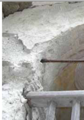
Deposito di sali e fenomeni di disgregazione e polverizzazione della malta dell'intonaco, a base di calce spenta male, provocato da umidità - Balmuccia, cappelletta loc. Dinelli
