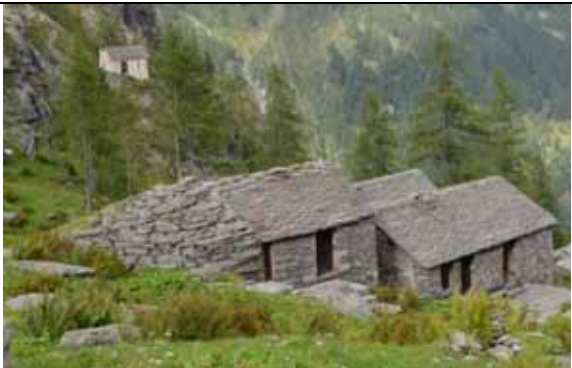
Baite con nuove coperture in pietra - Alpe Valmontasca
