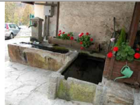
Fontana a bacino monolitico a base rettangolare, con acqua erogata tramite pilastrino, datato 1868, affiancata da lavatoio realizzato a lastre assemblate, datato 1879. Complesso coperto da tetto in piode. - Piode, fraz. Piedimeggiana
