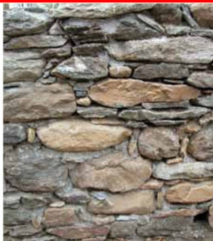
Nuovo muro con pietre posate con malta cementizia
