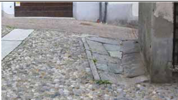
Strada con canalina a scivolo laterale - Maggiore
