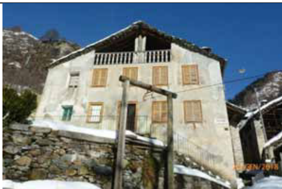
Casa a volume compatto, facciata chiusa, con solo il sottotetto ventilato - fraz. Campo Ragozzi
