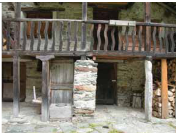
Campionario di montanti del loggiato: piedritti in legno con capitelli a stampella, pilastri in muratura di pietrame legato con malta, elementi monolitici - loc. Quare
