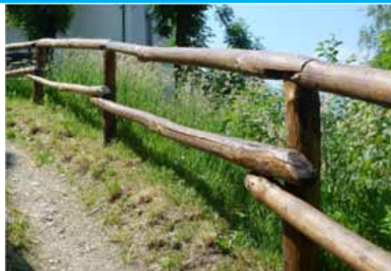
Staccionata rustica in legno di larice trattato in sito con vernice protettiva. I pali sono infissi nel terreno; le traverse inferiori sono fissate lateralmente e quelle superiori sono inchiodate in sommità ai pali. - Rimella, fraz. Sella
