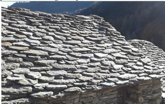
Rossa: vecchio manto in piode di dimensioni e formato irregolare, con la tipica posa 'a mosaico', ossia senza corsi, ma con sistema simile alla posa delle pietre nei muri a secco
