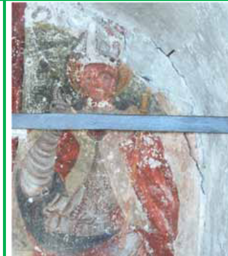
Consolidamento statico mediante posa di nuovo tirante metallico - Boccioleto, fraz. Piaggiogna
