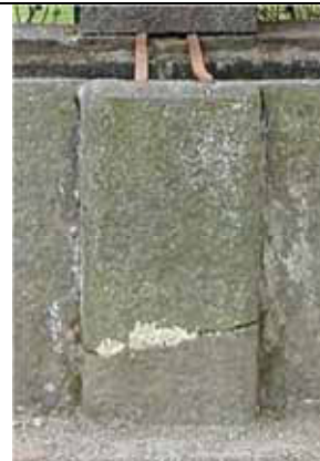
Fontana asciutta e abbandonata al degrado, che presenta danni meccanici con dislocazione degli elementi lapidei e frattura di una lastra (due foto sopra – anno 2003) - Scopello
