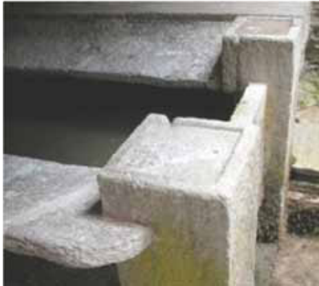
La base superiore dei pilastri angolari è stata lavorata in modo da costituire un piano d'appoggio con colatoio – Mollia, fraz. Piana Fontana
