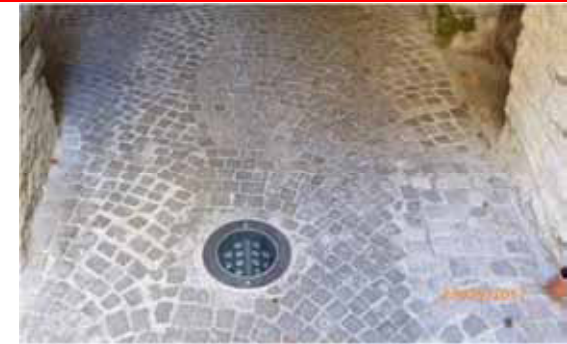
I ripristini del manto in cubetti di porfido (materiale estraneo alla litologia del luogo!), eseguiti a seguito di interrimento impianti, si notano troppo in quanto non riprendono il disegno della pavimentazione precedente e i giunti tra i cubetti sono più larghi e sigillati con troppa malta
