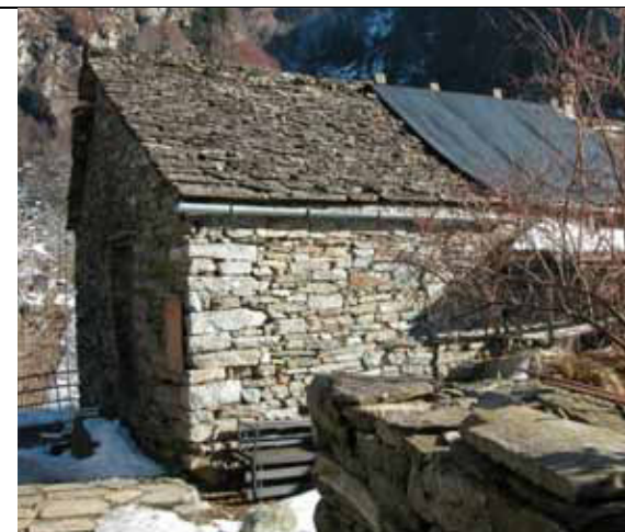
Tetto con vecchio mante in piode - fraz. Priami
