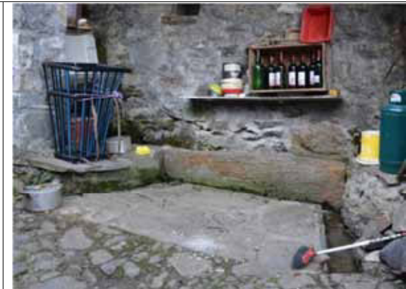
Abbeveratoio a vasca monolitica, canalina di scolo realizzata nella pavimentazione lastricata - Rassa, fraz. Rassetta
