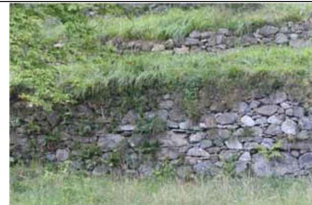
Muretti di terrazzamento con sommità inerbita - Cravagliana
