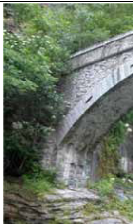
Sopra: degrado dovuto a vegetazione infestante, vicino e sulla struttura; erosione della malta nei giunti tra le pietre; fuoriuscita e caduta di elementi lapidei
