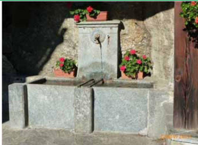
Restauro della fontana con pulitura della pietra, rimozione di alghe e licheni, rimozione di incrostazioni e depositi salini, revisione giunti e sigillature, sistemazione dell'area circostante - Rossa
