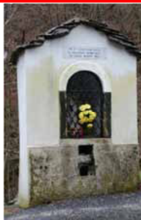
Zoccolo in cemento a finta pietra e tinteggiatura acrilica non traspirante
