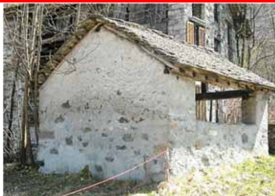
L'impiego di malta cementizia, sia come rinzafo sulle facciate esterne, sia come intonaco applicato nella parte bassa della parete, all'interno, ha accentuato i danni causati dall'umidità di risalita nel muro in pietrame, impedendone la traspirazione. Sulla muratura si vede la zona di degrado a circa 1,5-2 m da terra, corrispondente alla fascia al di sopra delle parti in cemento
