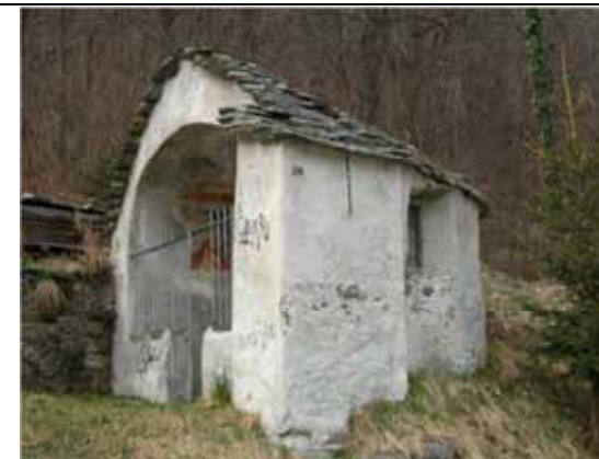
Cappella con abside semicircolare, muratura in pietrame intonacata, manto di copertura in pioda poggiante sull'estradosso della volta, vano interno affrescato - Scopello
