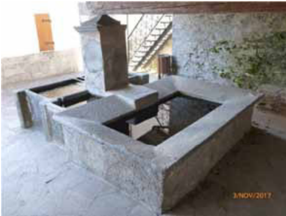
Interessante complesso con insolita aggregazione di tre vasche realizzate con belle lastre di pietra (gneiss): fontana, lavatoio e piccola vasca intermedia che riceve l'acqua dal troppo pieno della fontana, alimentata da bocca di erogazione posta sul pilastro centrale
