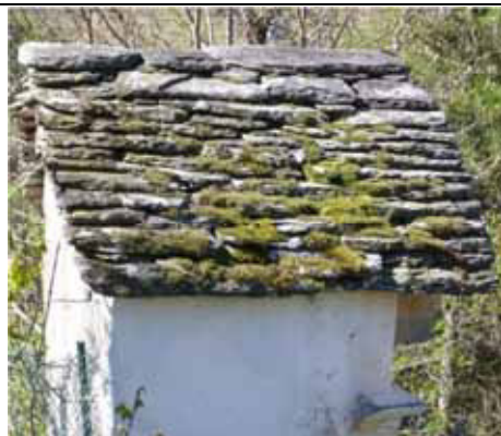
Tetti in cattive condizioni, con piode scivolate e smosse dalla propria sede, crescita di muschio - Cervatto, Via Crucis (foto 4-2015)
