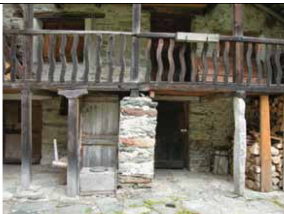
Campionario di montanti del loggiato: piedritti in legno con capitelli a stampella, pilastri in muratura di pietrame legato con malta, elementi monolitici - loc. Quare
