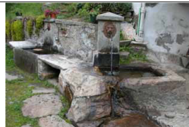
Fontana con bacino ricavato in un grosso masso di forma irregolare, provvisto di pilastrino con bocca di erogazione datato 1872; la fontana è affiancata da una vasca a lastre assemblate di epoca più recente, (1916) adibita a lavatoio – Rassa, fraz. Piana
