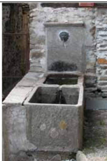
Due vasche rettangolari disposte in linea, alimentate a cascata – Boccioleto, fraz. Piaggiogna
