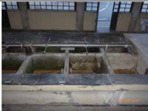
Lavatoio ancora attualmente utilizzato, costituito da una batteria di più vasche in cemento accostate, con scivolo rivestito da lastra in pietra - Serravalle
