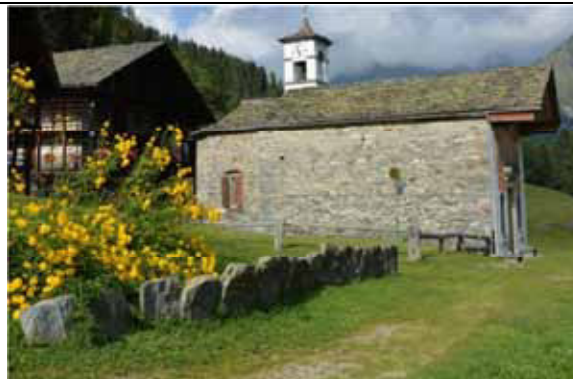
Spesse lastre di pietra rinvenute in sito, infisse nel terreno da quale fuoriescono per un'altezza di circa mezzo metro, delimitano il percorso separandolo dal pascolo - Alagna, fraz. Otro
