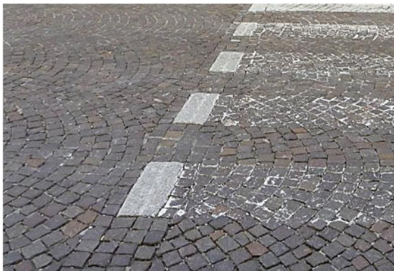
38- Serravalle: pavimentazione in cubetti di porfido
