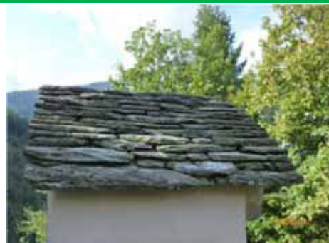
Revisione del manto di copertura in piode - Via Crucis, Cervatto
