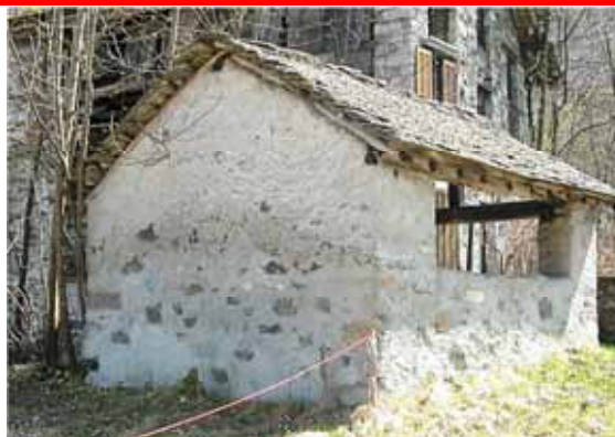
L'impiego di malta cementizia, sia come rinzafo sulle facciate esterne, sia come intonaco applicato nella parte bassa della parete, all'interno, ha accentuato i danni causati dall'umidità di risalita nel muro in pietra, impedendone la traspirazione. Sulla muratura si vede la zona di degrado a circa 1,5-2 m da terra, corrispondente alla fascia al di sopra delle parti in cemento
