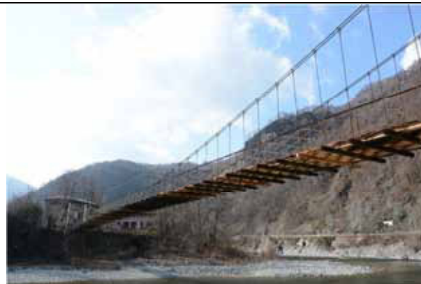
Ponte del Baraggiolo (Varallo) Di proprietà privata, venne costruito intorno al 1890. Si notano recenti interventi di manutenzione straordinaria con sostituzione di alcune travi e tavole dell'impalcato.
