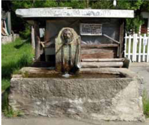
Grossolane e ridondanti risarciture eseguite con malta cementizia sul fianco esterno e sul bordo della vasca in pietra
