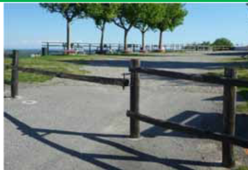
Recinzione con cancello a staccionata, di contenuto impatto visivo perchè particolarmente leggera ed essenziale (a differenza della staccionata a tre giri di traverse, visibile sullo sfondo) - Gattinara , Torre delle Castelle
