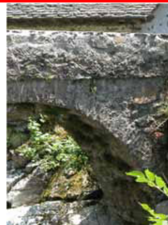
Sopra: interventi sulla muratura dei fianchi, delle spallette e dei parapetti, eseguiti con getto di calcestruzzo, o con impiego di intonaco cementizio. NON AMMESSI
