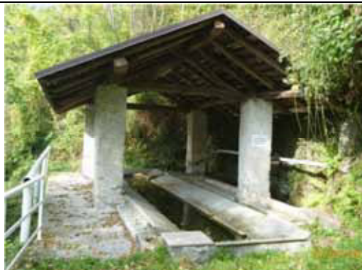
Lunga vasca solo parzialmente coperta da un tetto a due falde, ora in lamiera - Varallo
