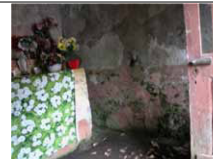
Patina biologica e degrado degli intonaci sulle pareti interne - Quarona, fraz. Doccio (p. privata)
