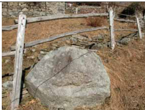
Staccionata in legno di tipo tradizionale con due file di traverse orizzontali inchiodate a pali infissi nel terreno senza cemento - Ca' Bastucco
