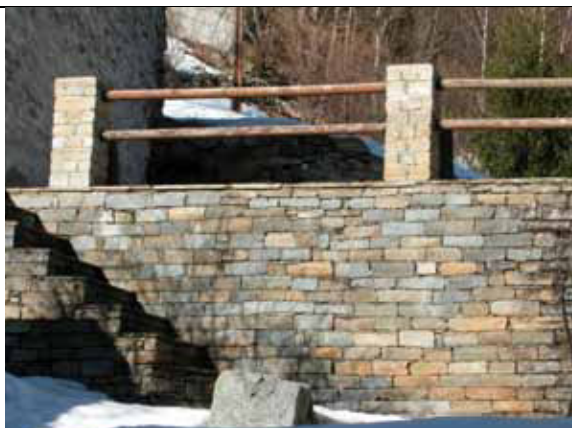
Muraglione in cemento armato ove la pietra (di nuova fornitura) è usata come rivestimento, analogamente ai pilastri del parapetto, con traverse costituite da elementi commerciali in legno di confiera tornito e pretrattato in stabilimento - fraz. Priami
