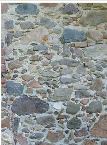
10- Ca' Negri (Grignasco): muro in elementi di dimensioni eterogenee di prevalenti vulcaniti (porfidi e piroclastiti)
