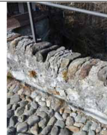
Sopra: degrado dovuto a vegetazione infestante, vicino e sulla struttura; erosione della malta nei giunti tra le pietre; fuoriuscita e caduta di elementi lapidei
