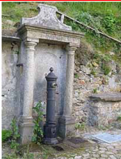
Rinzafo di malta cementizia su muri in pietra a secco
