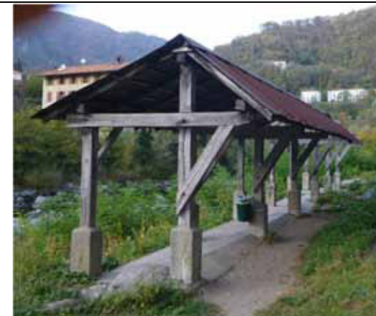
Eliminazione della vasca con cementificazione della vecchia roggia che costeggiava il torrente: cancellazione di un' importante memoria storica
