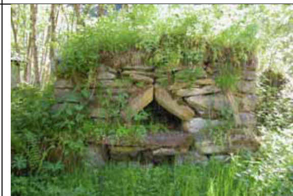
Rudimentale forno costruito in pietra, in stato di completo abbandono - fraz. Pie' di Fagiolo (foto 2003)
