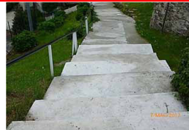
Vecchia mulattiera con rampe ricoperte da pastina di cemento: materiale inopportuno e dal forte impatto cromatico
