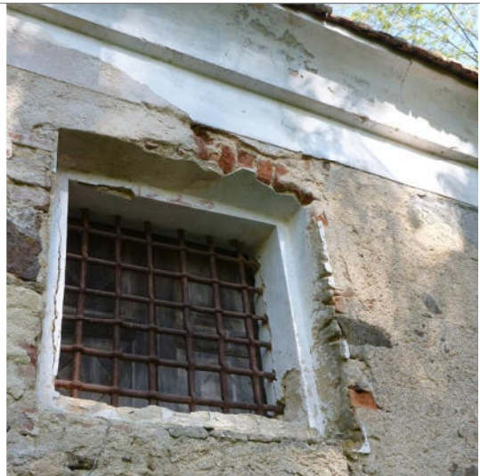
Muro esterno intonacato con malta di calce; cornicione e riquadro della finestra con finitura in marmorino (calce aerea, grassello, sabbia fine e polvere di marmo, nelle giuste proporzioni), tirato con ferro.
