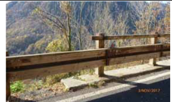
Barriera di sicurezza a fascia singola di acciaio mascherato da due tavole sovrapposte - Rossa (sopra e dettaglio foto a sinistra)
