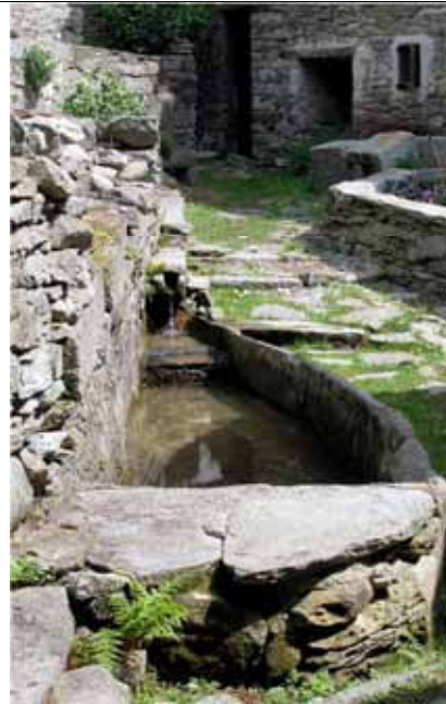
Abbeveratoio a canale basso e allungato: da un lato è addossato a un muretto, mentre l'altro lato è realizzato con lastre di pietra messe di taglio. Dettaglio della pietra scavata (una sorta di canale) per l'erogazione dell'acqua, datata 1878 - Mollia fraz. Piana Fontana (foto sopra e a lato – anno 2003)
