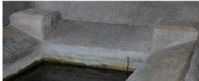
Nell'ottica dell'economia di tempo e fatica, la pietra veniva lavorata con cura solo nelle superfici a vista e nelle parti funzionali, come lo scivolo su cui fregare i panni e il pilastro angolare, lasciando più grezze le altre superfici, come il lato inferiore della lastra posta a scivolo (sopra e a destra) – Scopello, fraz. Chioso
