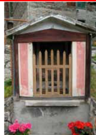
Tetto e basamento realizzati in cemento
