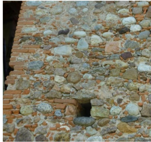
15- Garodino (Grignasco): muro in pietrame eterogeneo proveniente dal greto del Sesia con cantonali in laterizio
