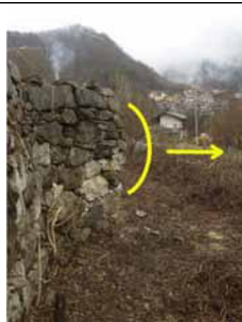
Spanciamento della parte mediana del muro
