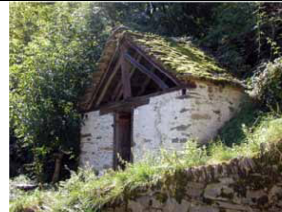
Edificio quasi totalmente chiuso Boccioleto, fraz. Palancato
