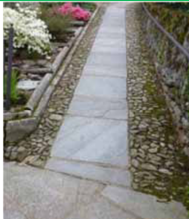
Rifacimento di pavimentazione in pietra - Varallo, fraz. Cavaglia Sterna
