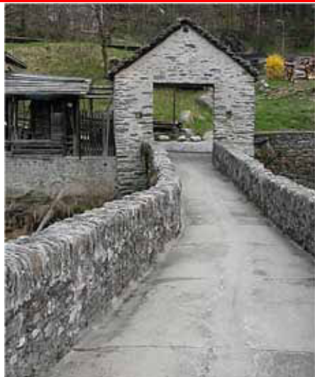
Cappa in pastina di cemento che cancella la vecchia pavimentazione in pietra
