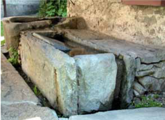
Fianchi realizzati con quattro spesse lastre di pietra locale a finitura esterna rustica. Un incavo funge da troppo pieno e, a pavimento, una canaletta perimetrale alla vasca raccoglie l'acqua di scarico - Mollia, fraz. Casaccio
