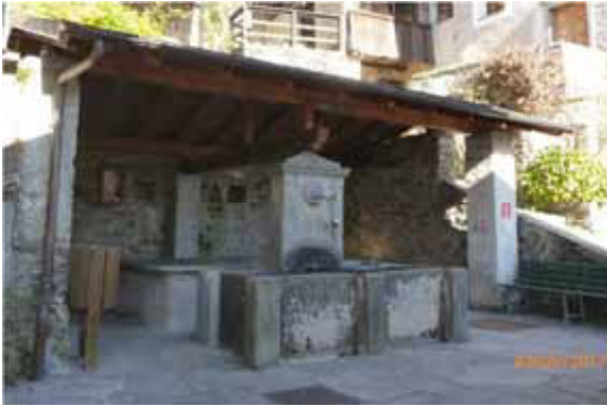
Ubicato in una piazzetta nel centro del paese, il complesso coperto con lavatoio e fontana associati costituiva un fulcro di aggregazione sociale - Rossa (foto sopra e sotto)
