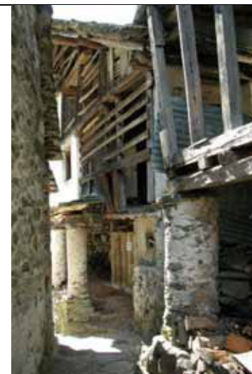
Casa con loggiati lignei retti a piano terra da pilastri di sezione tonda, di influenza provenzale, frequenti in quest'area - fraz. Pie' di Fagiolo (foto 2003)
