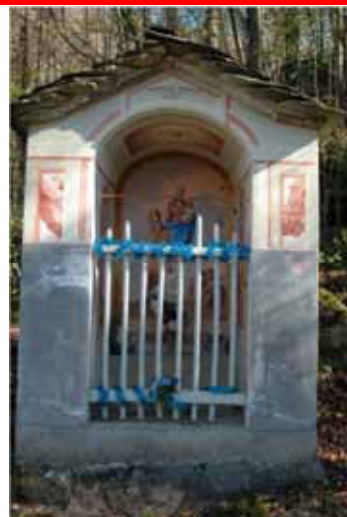
Rifacimento con malta cementizia dell'intonaco della parte inferiore dei pilastri di facciata
